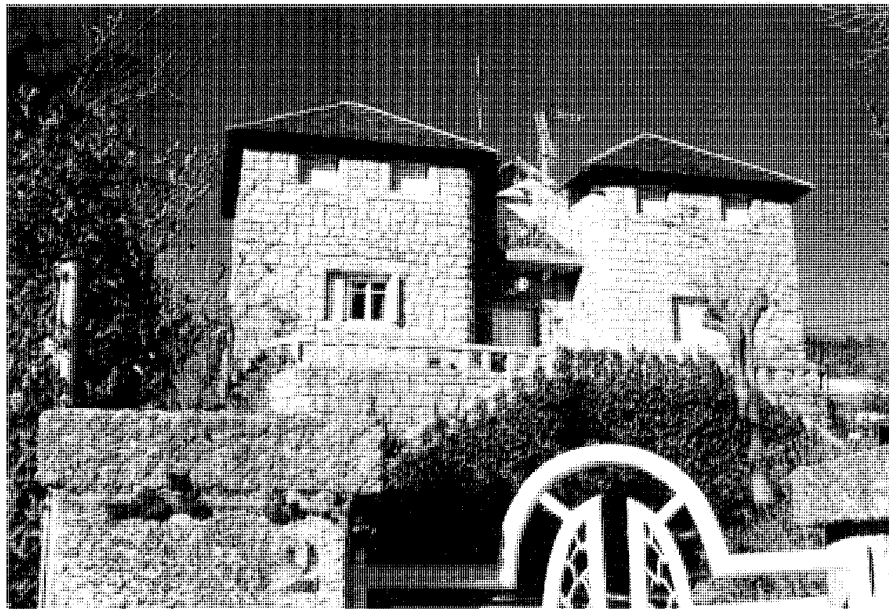
Avenida de Calvo Sotelo, 82 ("Villa Matilde"). Fot. Pilar Martín Serrano.
