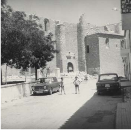
Iglesia de Villarejo de Salvanés. Estado previo
