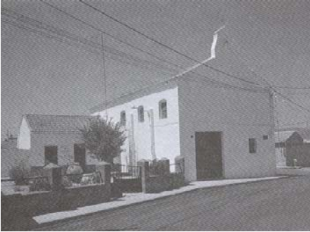
Iglesia de las Peralosas. Estado actual
