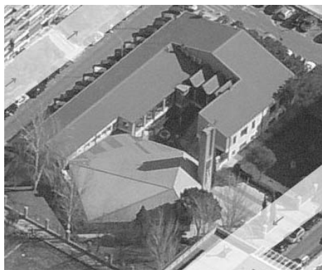
Parroquia de San Saturnino. Estado actual
