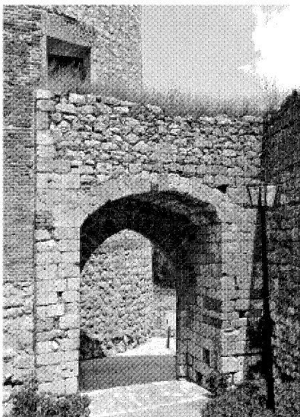
Puerta de la muralla adosada a la torre. Foto Actividades y Servicios Fotográficos.
