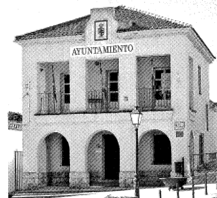
Ayuntamiento. Fachada principal. Foto Gonzalo López-Muñiz.
