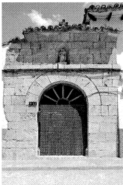
Portada del Hospital de la calle Amparo. Foto Actividades y Servicios Fotográficos.
