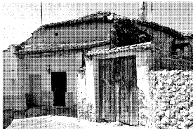
Vivienda de la calle del Agua, 30. Foto Gonzalo López-Muñiz.
