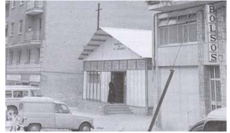
Capilla prefabricada de San Eduardo, Madrid, 1967.
