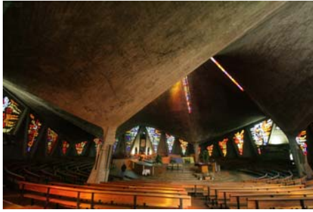
F. Candela y E. de la Mora: Iglesia de Nuestra Señora de Guadalupe, Madrid, 1962.
