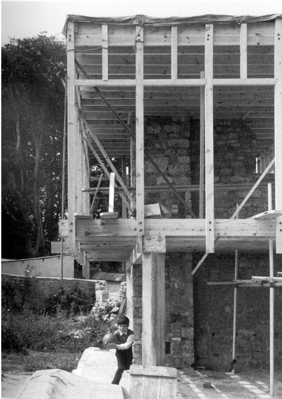
Figura 2.79 El pabellón en construcción. Construcción de ligera con entramado de madera. Simon Smithson jugando (Smithson y Smithson 1986). (Smithson y Smithson 1986). Imagen superior izquierda: La estructura descubierta sobre las ventanas de la planta alta. Julio 1961
