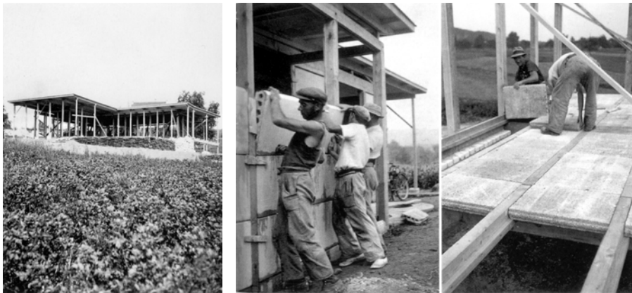
Colocación de los elementos de hormigón ligero Durisol sobre estructura común de maderal. Paneles estandar de la empresa Durisol AG de Dietkon Zurich, que hasta entonces solo se habían utilizado en edificios industriales
