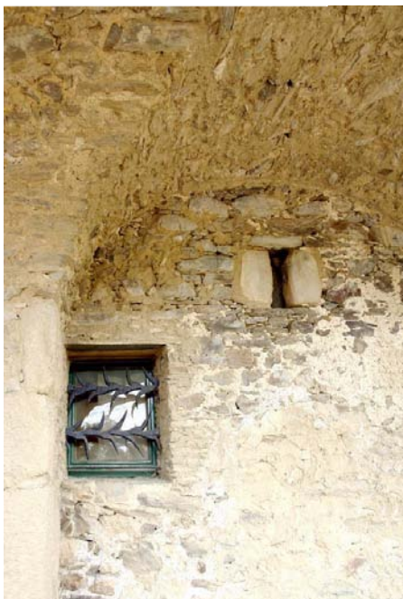
Figura 4.43 Croquis del espacio abovedado de planta baja con los muebles e iluminación previstos. Archivo Coderch * Interior Fotografías de huecos en la planta baja que dan a la galería. El principal a la derecha fue abierto por Coderch en la intervención, realizando para ello un inusual acuerdo entre las superficies abovedadas. Fotografías de Ana Rodríguez
