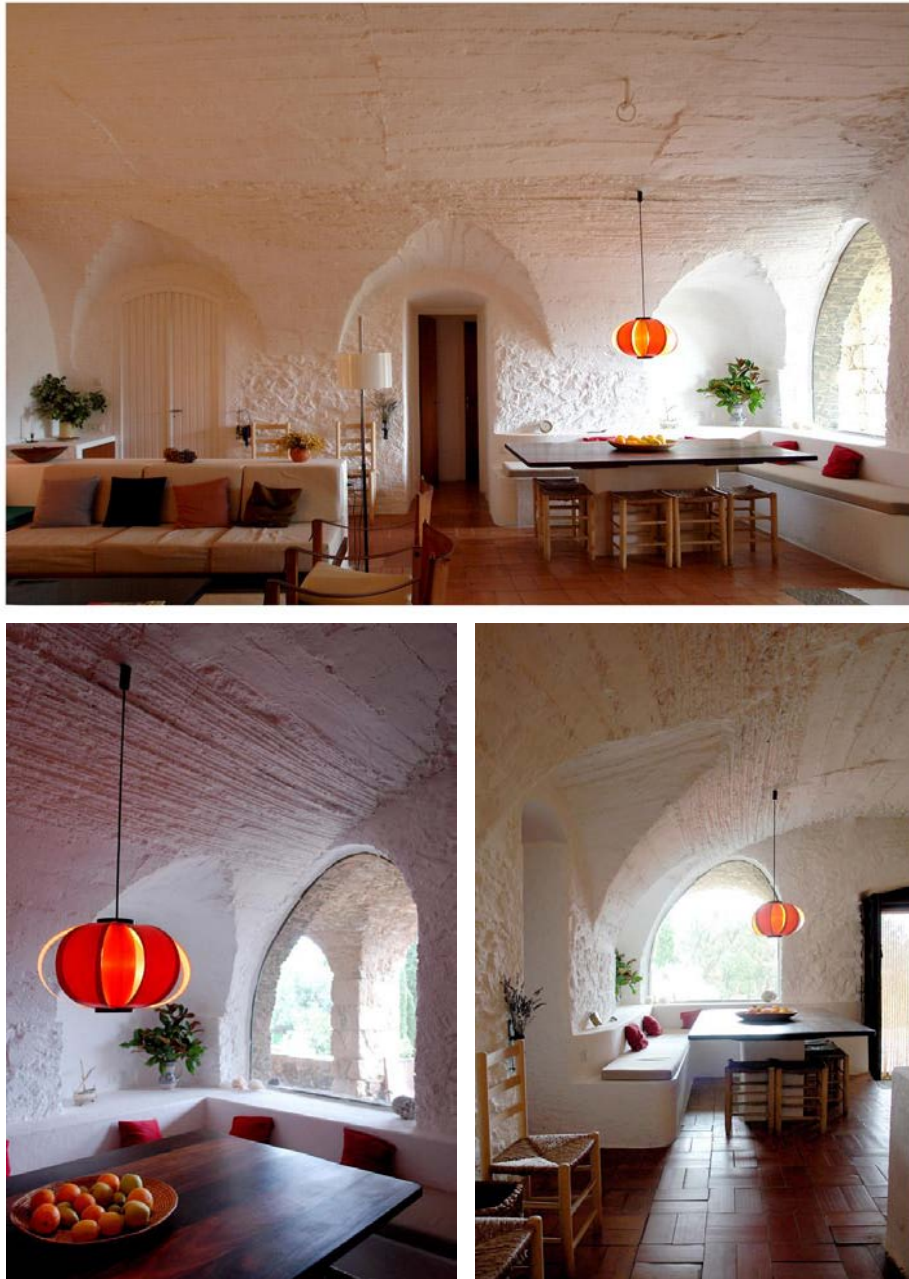
Figura 4.48 Fotografías de la Casa en Espolla realizadas por Ana Rodríguez García En ellas se aprecia con claridad la textura y características de las bóvedas construidas sobre encofrado de tierra y cañizo.
