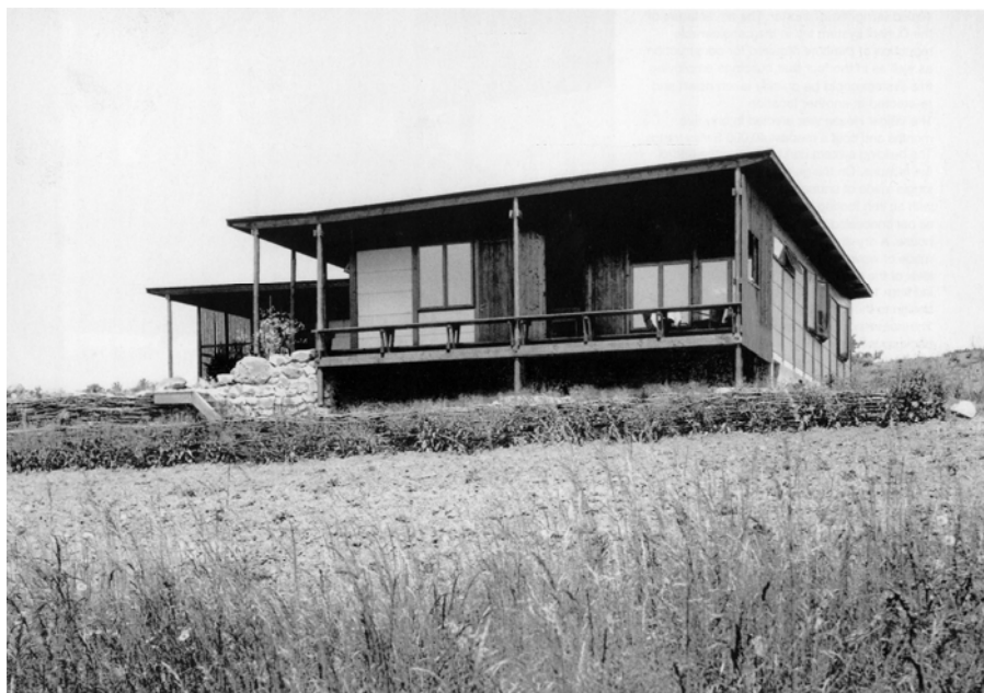
Colocación de los elementos de hormigón ligero Durisol sobre estructura común de maderal. Paneles estandar de la empresa Durisol AG de Dietkon Zurich, que hasta entonces solo se habían utilizado en edificios industriales
