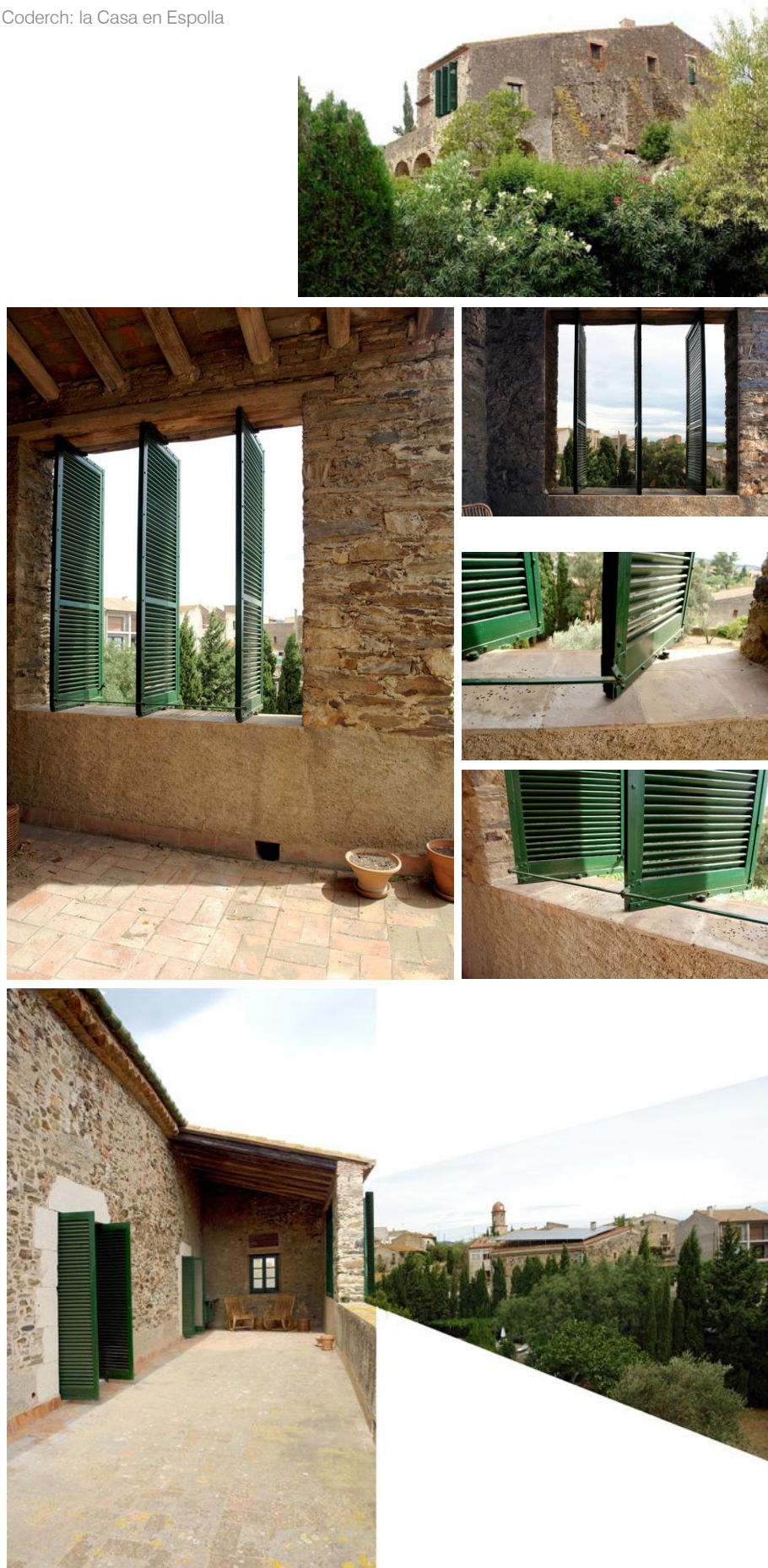
Figura 4.45 Ventana al paisaje, como una de las intervenciones que caracterizan la casa, con una interpretación de la persiana de tablilla de madera. En este caso, tres hojas verticales de gran tamaño, se mueven solidariamente pivotando sobre ejes verticales, mediante un sencillo sistema de accionamiento mecánico horizontal. Fotografías de Ana Rodríguez García
