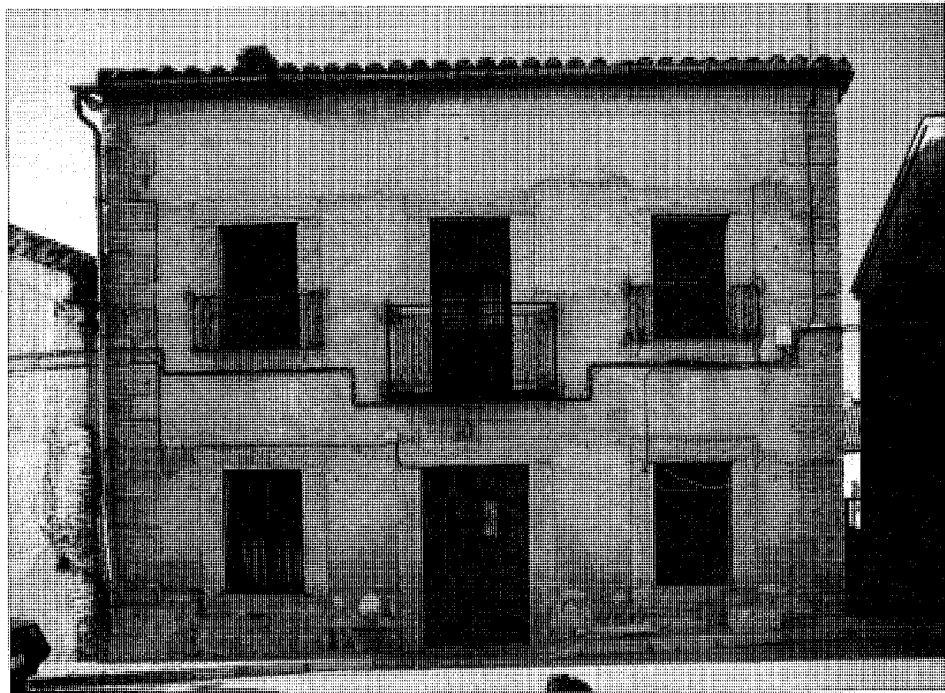
San Mamés. Vivienda en la calle de la Fuente
