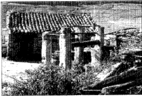
Paredes de Buitrago. Conjunto de fragua y potro en la calle de la Fragua
