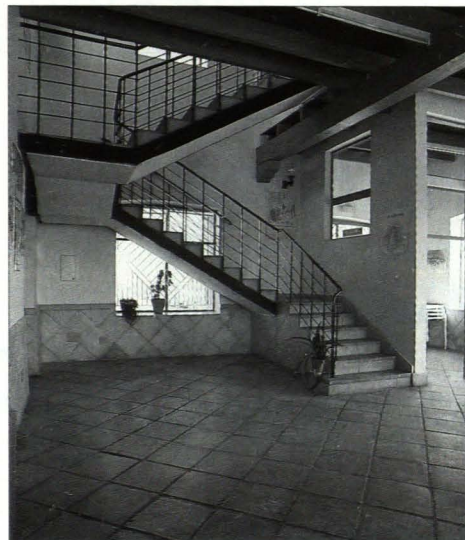
Escalera. Edificio principal.
