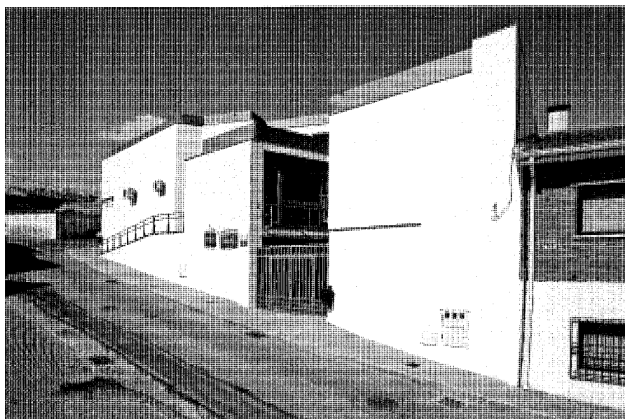
Fachada de la calle Cruces.
