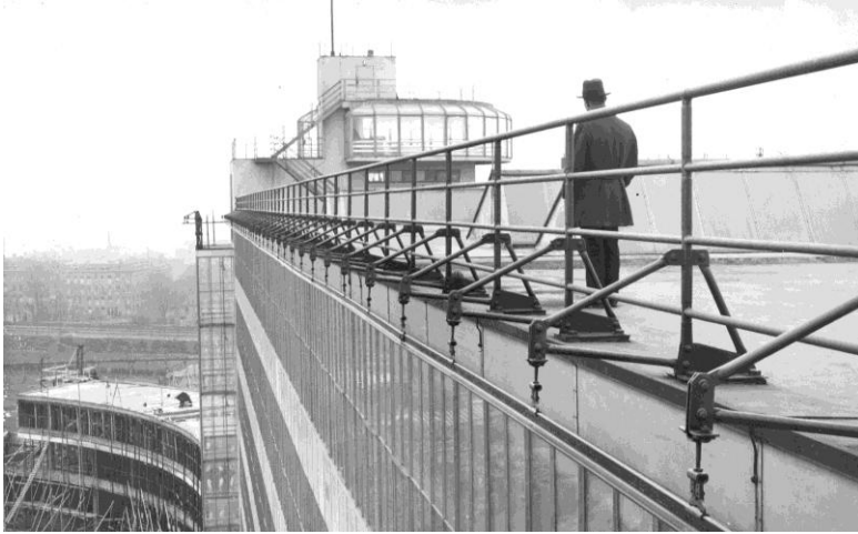
[Fig11] Remate de cubiertafábrica Van Nelle. Brinkman & Van der Vlugt (Rotterdam), 1930
