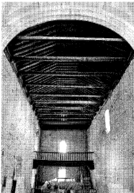
Nave con vista hacia el coro. Cubierta en de artesa que la nave. Foto José Ablanedo.
