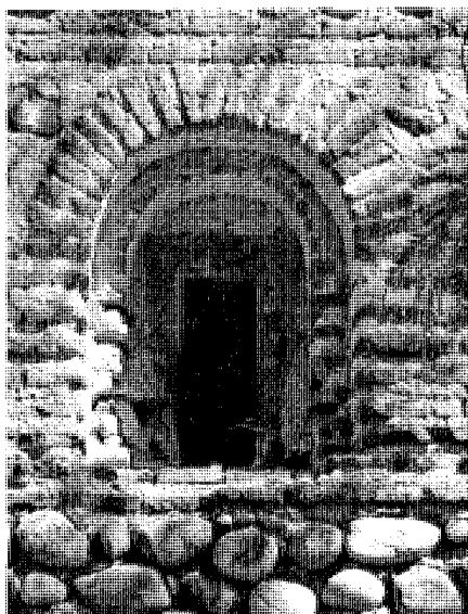
Huecos de la torre. Foto José Ablanedo.
