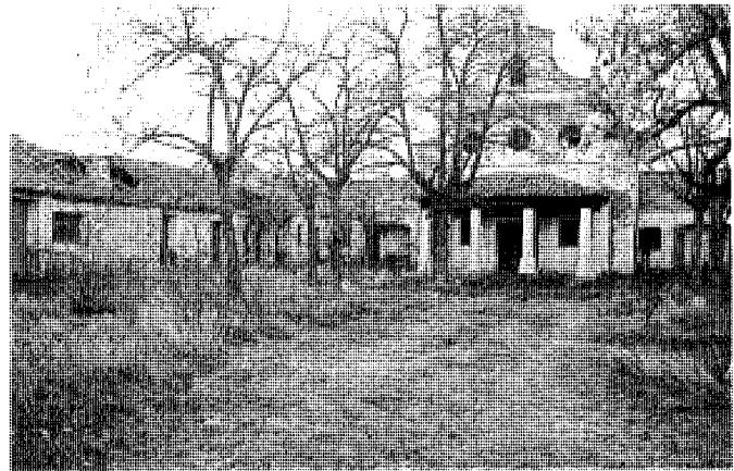
Vista de la fachada de la capilla y plaza de la colonia.
