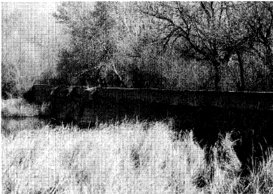
Vista de la presa. Foto Alberto Sanz.
