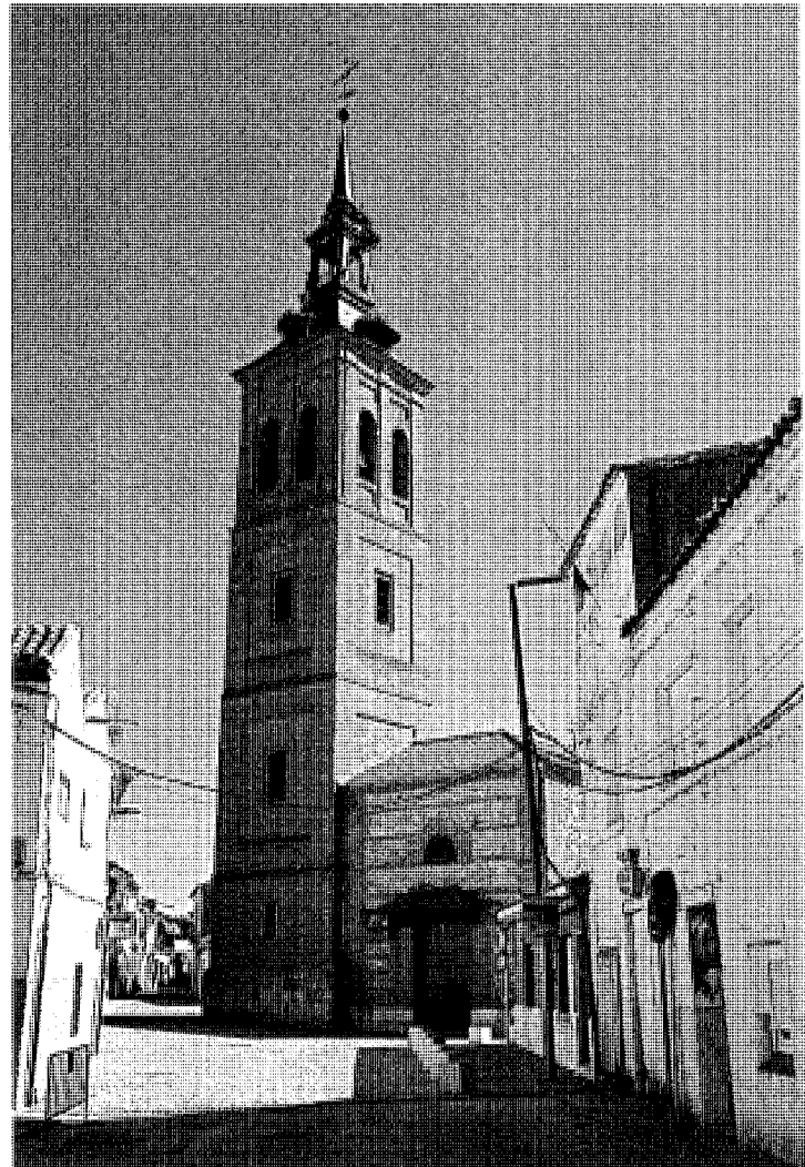
Vista de la torre y acceso desde la calle Iglesia.
