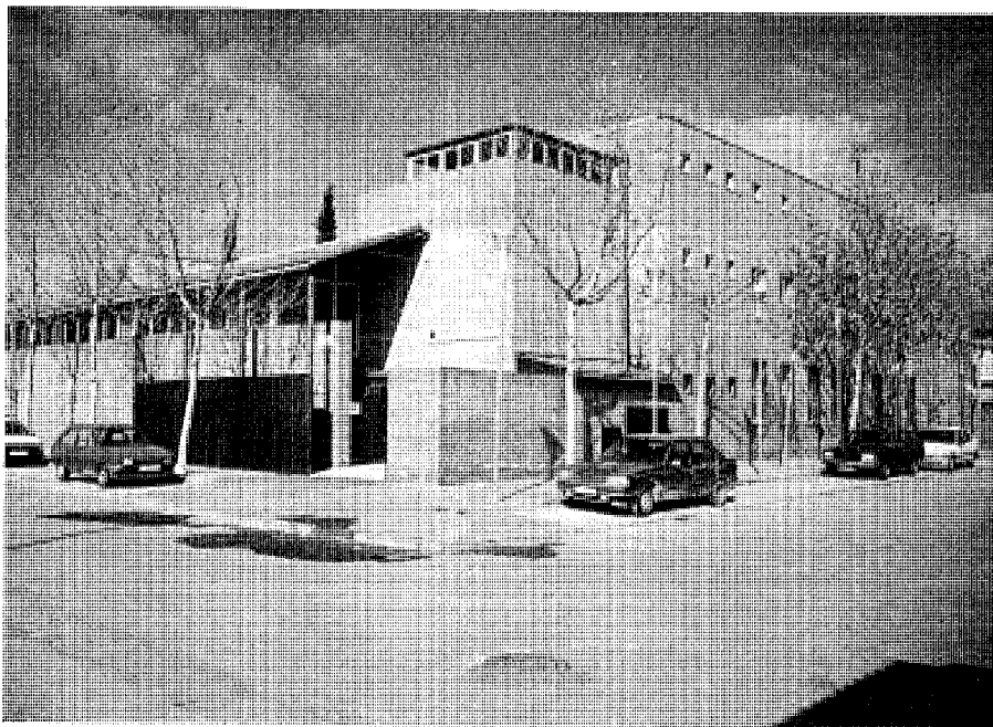
Vista del acceso principal. Foto Alberto Sanz.
