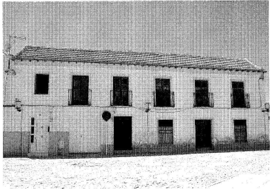
Vivienda en calle Iglesia, 28.
