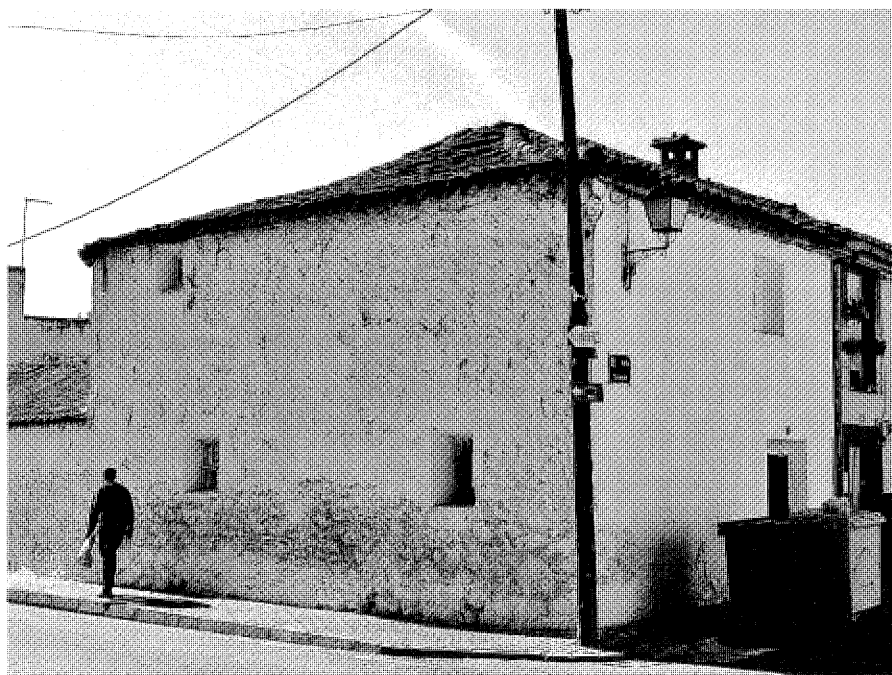
Vivienda rural en el nº 1 la calle de Tintoreto de Los Hueros. Foto Vicente Patón.
