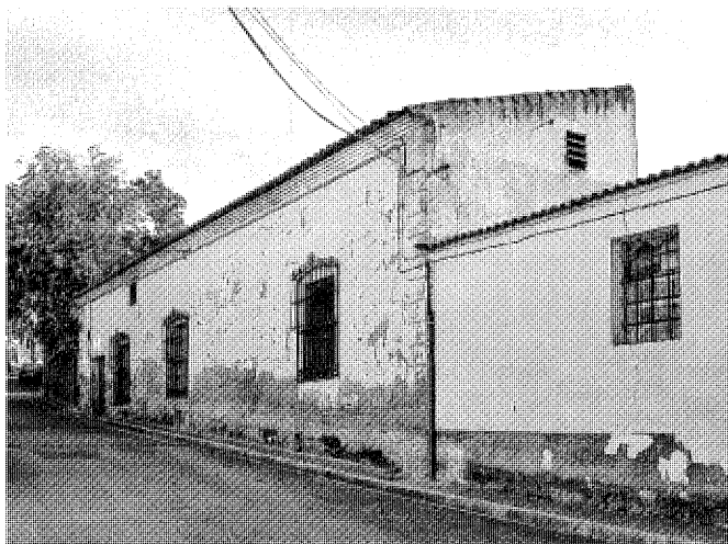
Vivienda urbano-rural en la calle de la Plazuela, nº 17. Foto Vicente Patón.
