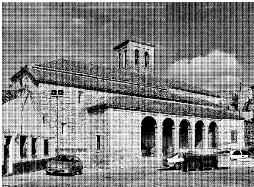
Fachada meridional con el pórtico antepuesto. Foto Vicente Patón.
