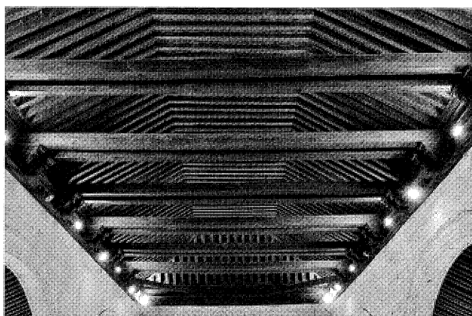
Detalle de la cubierta de par y nudillo de la nave central. Foto Vicente Patón.
