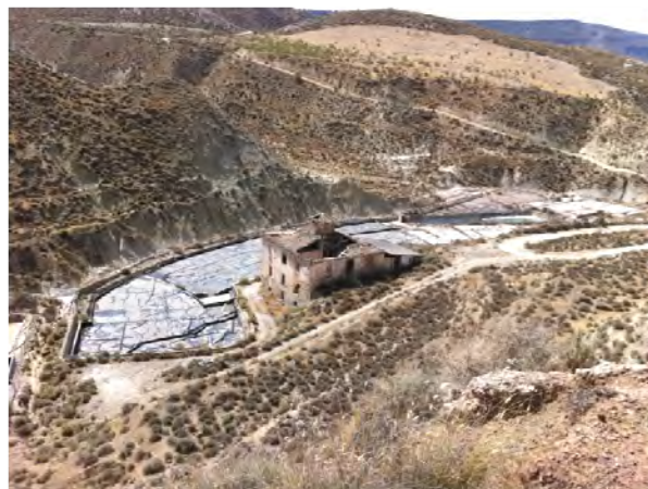
Casa salinera y eras de evaporación
