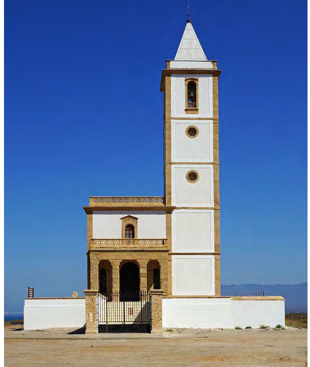
Fotografía: Digby Merry
