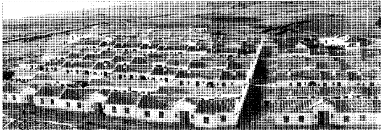
Vista general de las seis manzanas de conjunto. Estado original. A.G.A. Regiones Devastadas.
