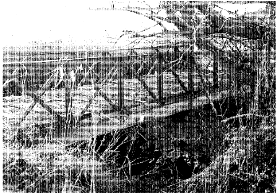
Puente metálico sobre el Tajuña en el límite con Carabaña. Foto Vicente Patón Jiménez.
