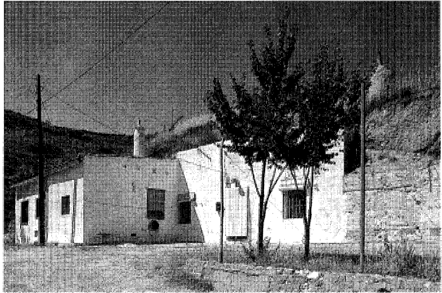
Una cueva rehabilitada en el barrio de Cuevas Altas. Foto Actividades y Servicios Fotográficos, S.A.
