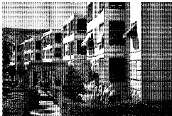
Viviendas del IVIMA en el Paseo de la Estación. Vista general. Foto Actividades y Servicios Fotográficos, S.A.
