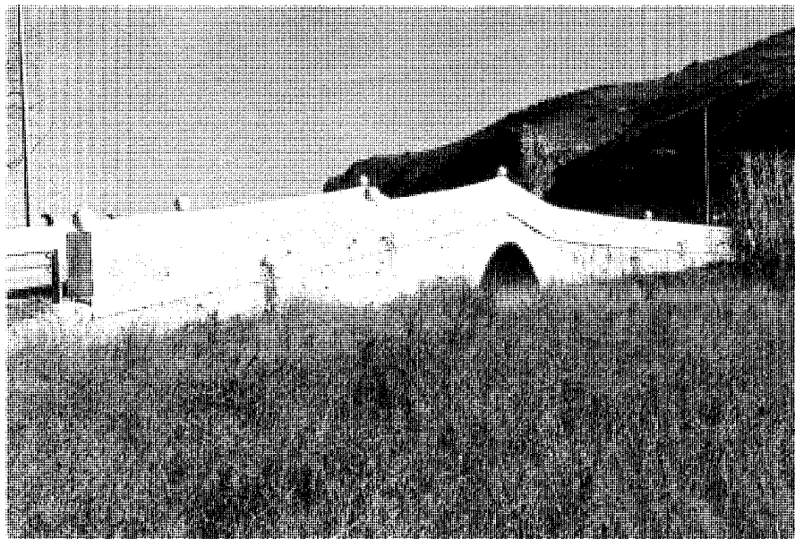
Puente Viejo. Costado occidental desde el norte. Foto Vicente Patón Jiménez.
