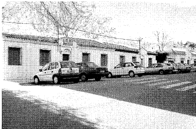
Grupo Nuestra Señora de la Soledad en calle Real, 107-123. Arquitecto Rafael Fernández Huidobro, 1943.
