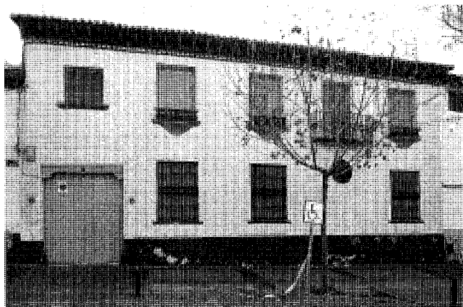
Vivienda en calle Real, 68
