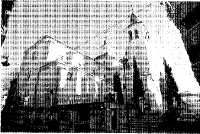
Fachada occidental y torre.
