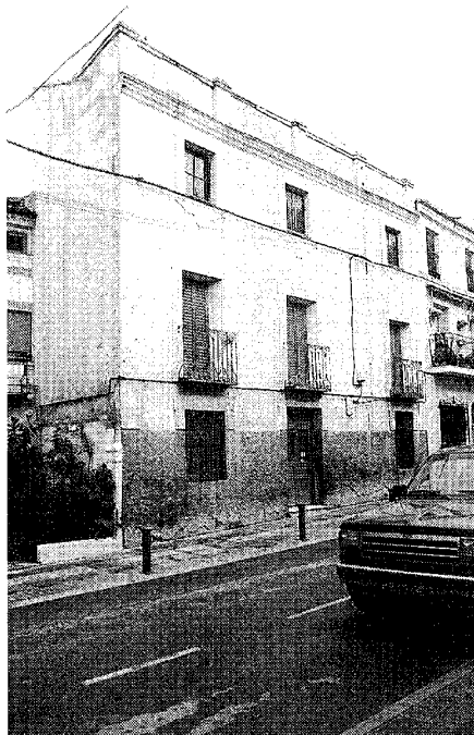
Vivienda en calle Real, 15. Foto Virginia Torres
