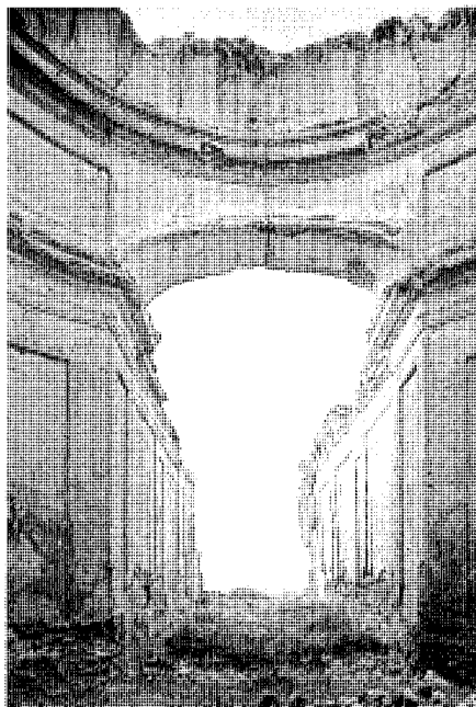
Iglesia. Restos nave desde cabecera.
