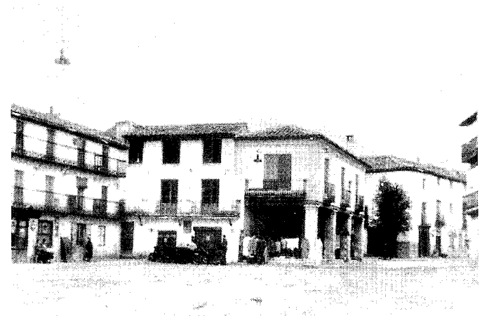
Soportales y Casa de la Prevención en 1958. Arganda del Rey: imágenes para el recuerdo: la fotografía en Arganda del Rey.
