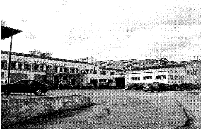
Vista del acceso.
