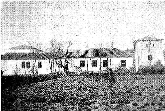
Vista general del monasterio después de su reconstrucción. AGA Regiones Devastadas
