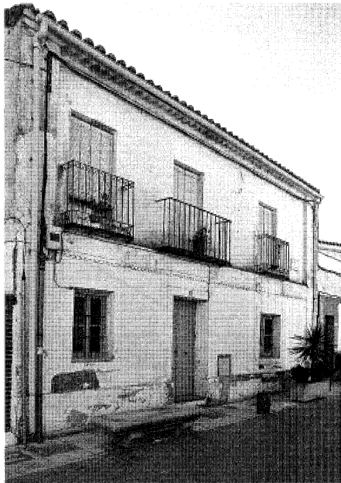
Vivienda de la calle Sagrado Corazón, 17. Fot.: José Ablanedo
