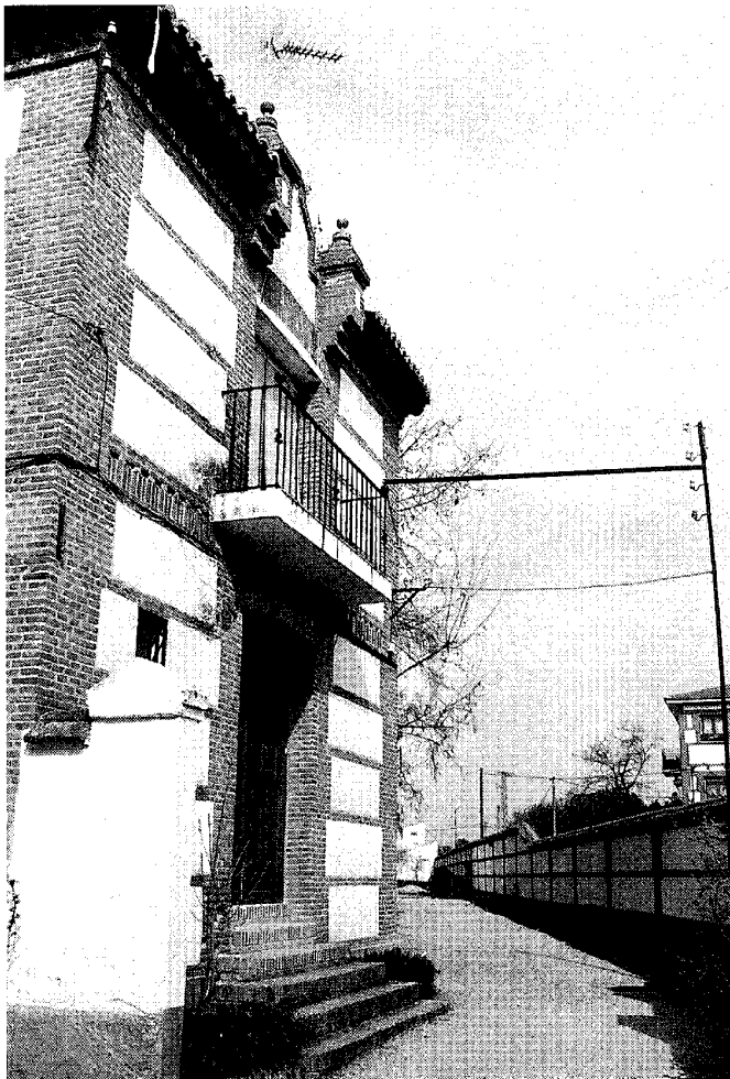
Fachada principal. Fot Pilar Martín-Serrano
