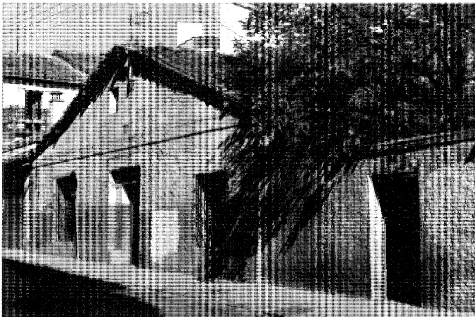
Vivienda rural de la calle María Santos Colmenar.
