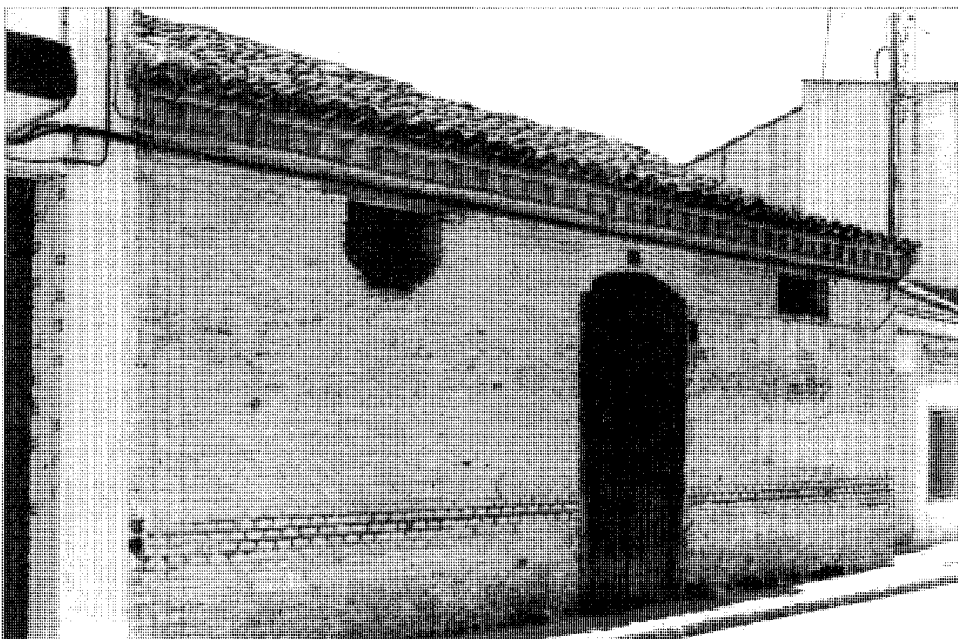
Almacén de la calle Higueras, 21.
