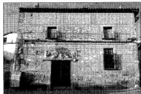
Calle Burgos, 3 c/v Montera. Fachada principal
