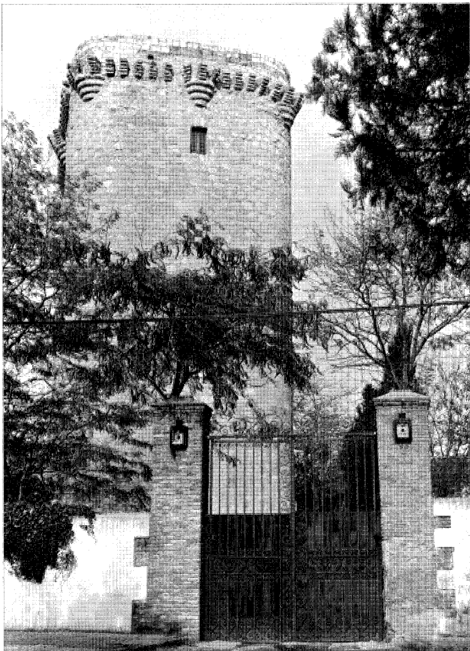
Vista desde la entrada al Parque.
