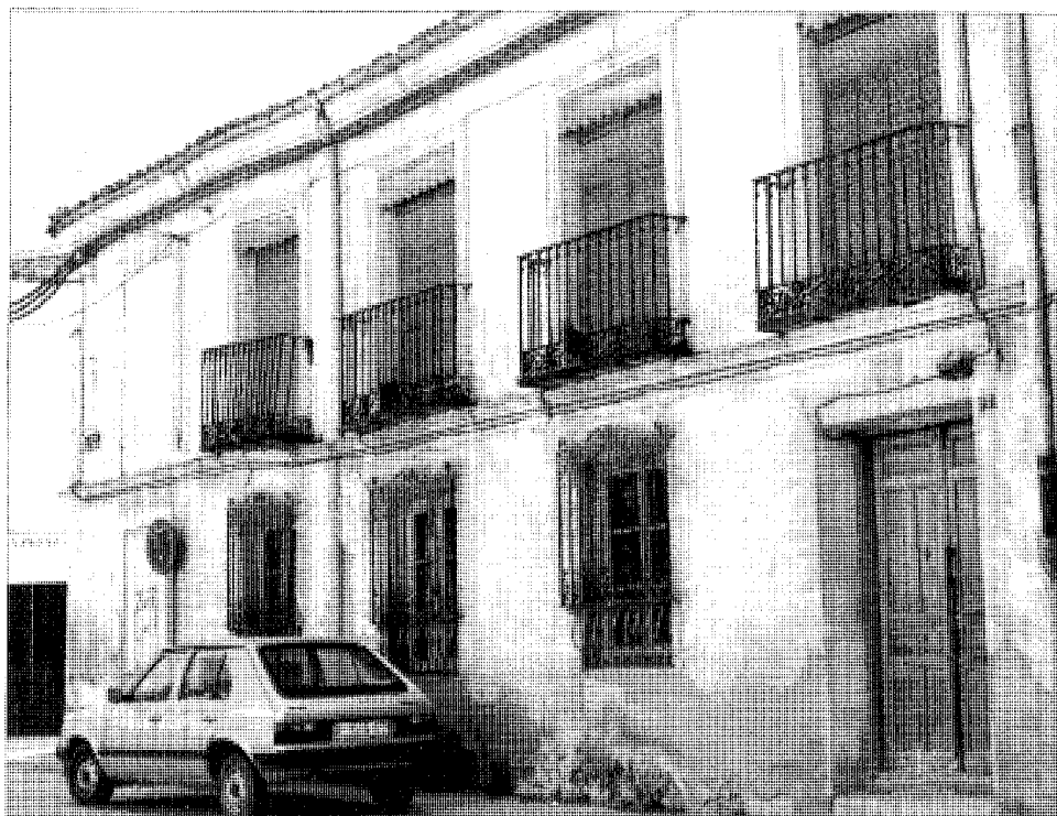
Vivienda. Calle Monjas, 3.
