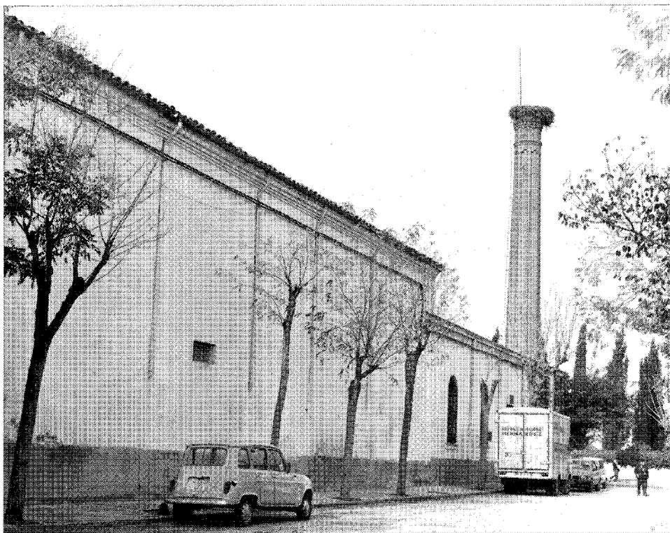
Fachada lateral y chimenea.
