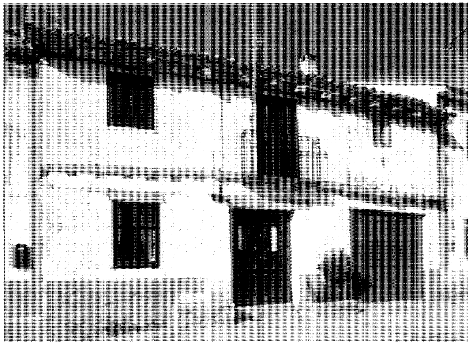
Vivienda en la calle Real
