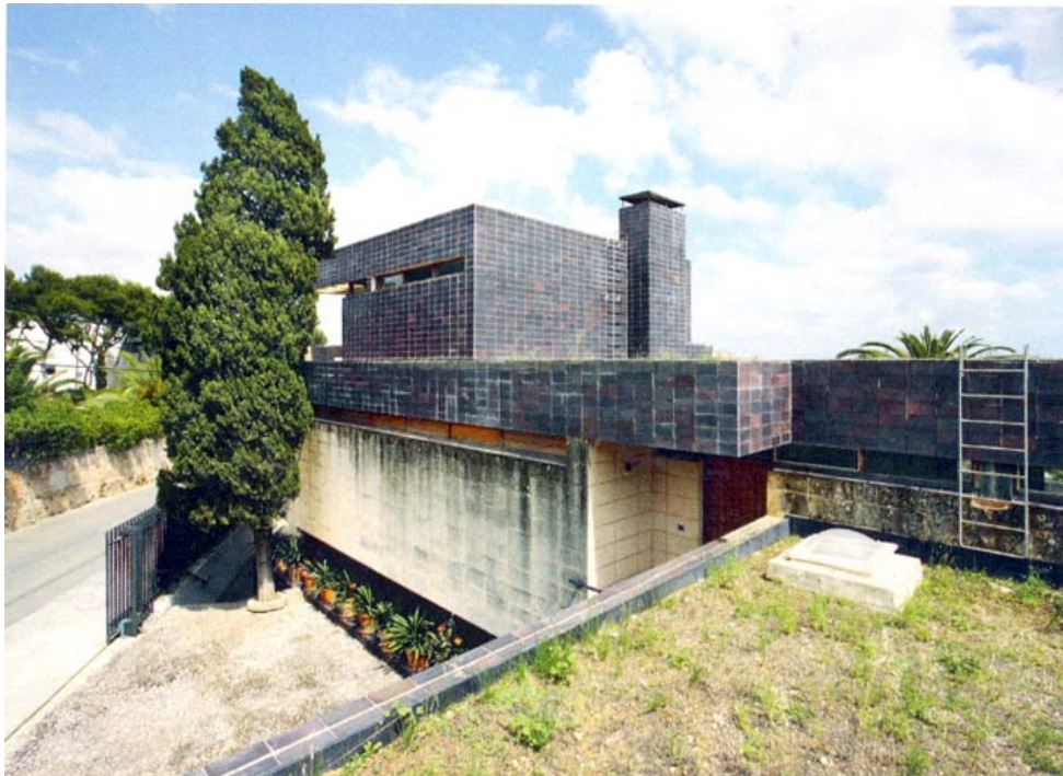
Figura 9. Corrales y Molezún. Casa Cela. Porto Pí, Mallorca, 1962. Fachada norte desde la cubierta del garaje. Fotografía: José Hevia, publicada en "La vivienda moderna, Registro Docomomo Ibérico, 1925-1965", Fundación Caja de Arquitectos/Fundación Docomomo Ibérico, 2009
