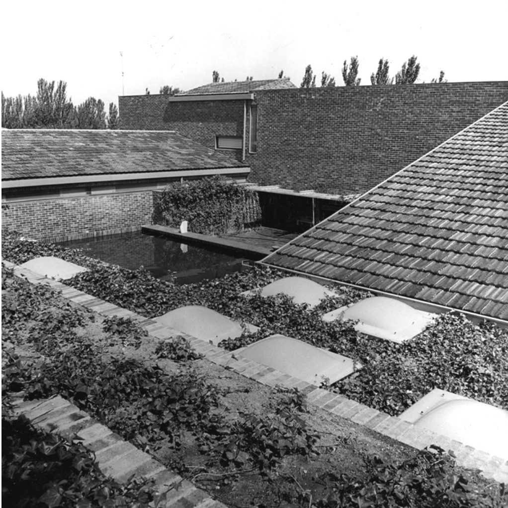
Casa Huarte. Vista del patio de hijos desde la cubierta del pabellón de servicio. Fotografía: archivo Huarte
