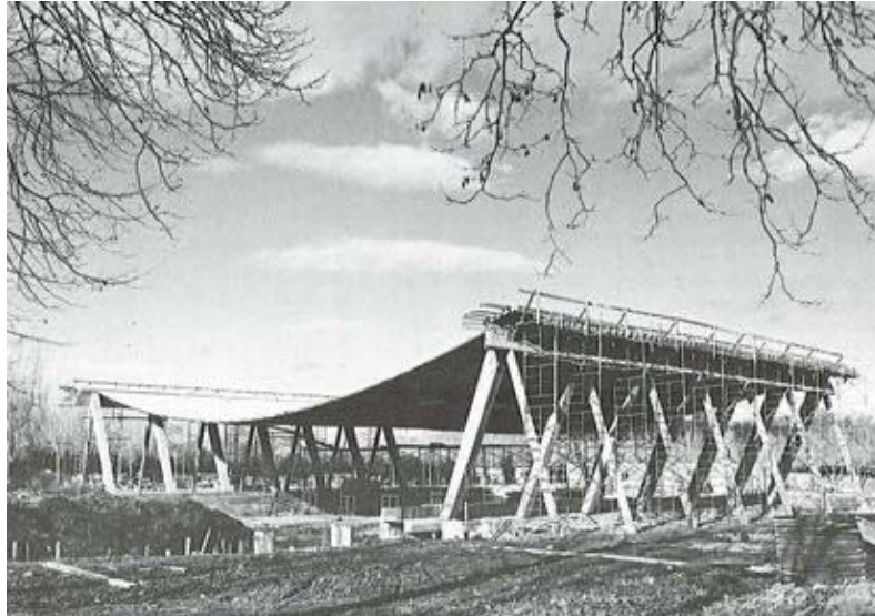
José Antonio Domínguez Salazar y Carlos Fernández Casado. Picadero Cubierto del Club de Campo, Madrid, 1961. Constructora: Huarte y Cia, S.L.
