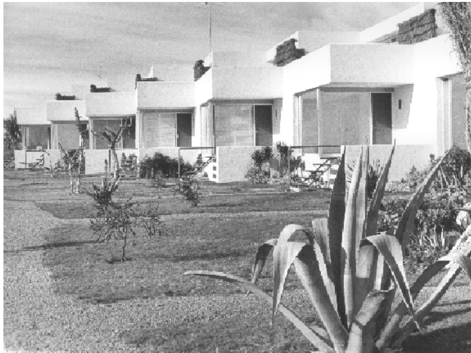
Corrales y Molezún. 25 bungalows . Hacienda Dos Mares, La Manga del Mar Menor, Murcia, 1966. Fotografía: Legado Vázquez Molezún. Fundación COAM
