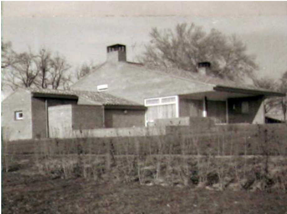
Corrales. Casa Luelmo. Granja Minaya, Valladolid, 1965. Fotografía: Archivo Corrales
