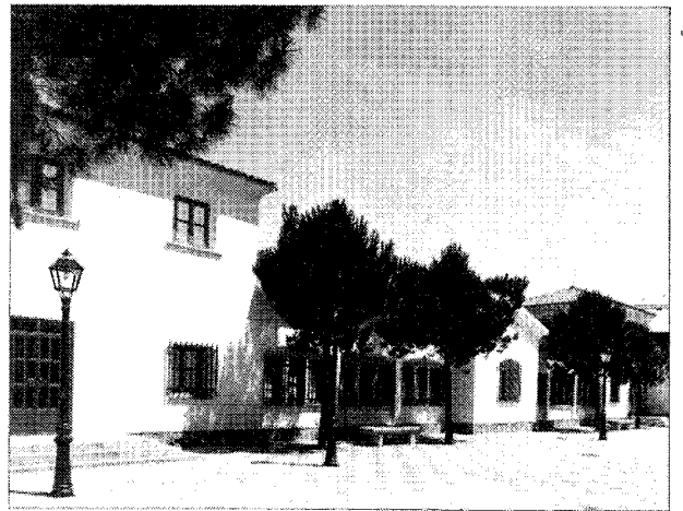
Detalle de un ala. Estado original. A.G.A. Regiones Devastadas.
