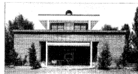
Fachada posterior tras la reforma.
