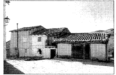
Cortijo en la parte baja del pueblo
