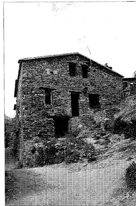
Edificación aislada, con cubierta a dos aguas
