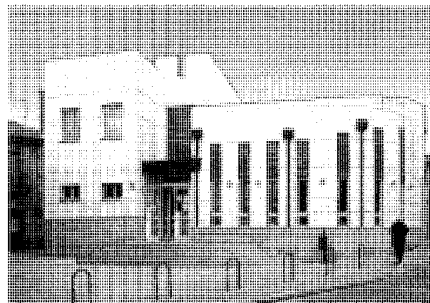
Consultorio municipal, realizado en 1989, según proyecto de Paloma Hoyo. Fot. José Rodríguez Ablanedo.
