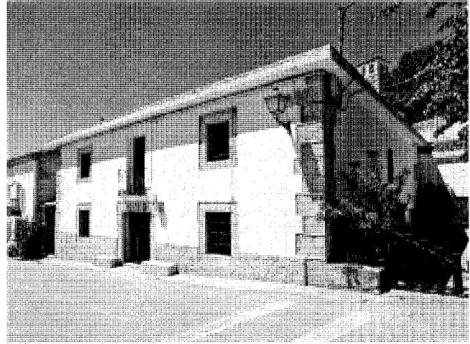
Vivienda rehabilitada en la calle Mayor, nº 45.
