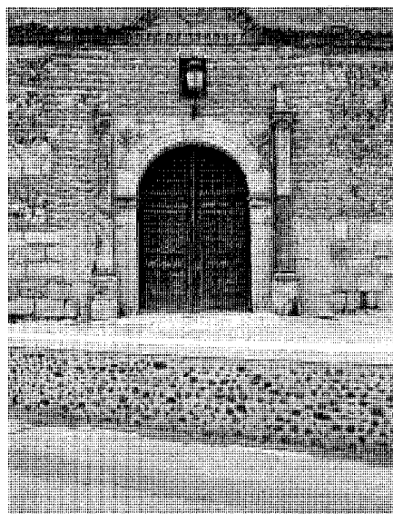
Detalle de la portada principal. Foto José Ablanedo.
