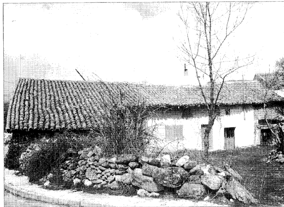
Conjunto de vivienda y edificación auxiliar. Foto L. Acevedo
