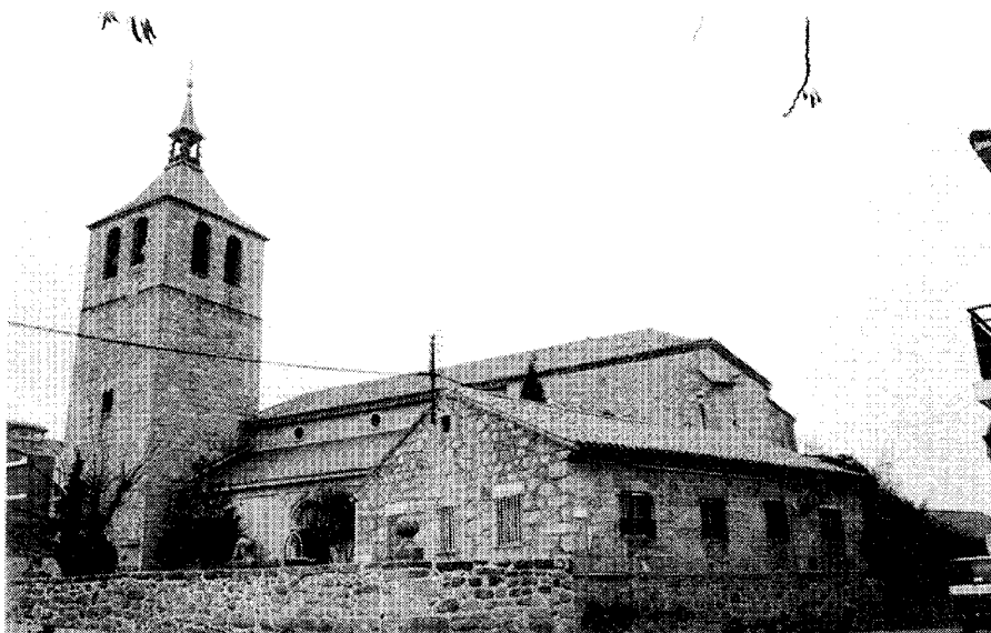
Vista de conjunto desde el encuentro de la calle San Gregorio con la Plaza de la Iglesia. Fot. Cristina García.
