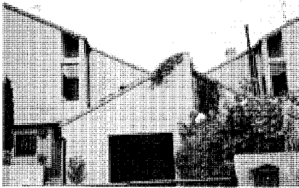
Conjunto de adosados en la Urb. Parquelagos, años noventa. Fot. Pilar Martín-Serrano.
