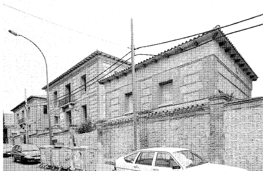
Vista de la fachada principal. Fot: Actividades y Servicios Fotográficos S.A.
