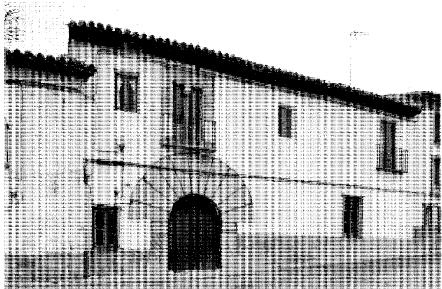
Vivienda en calle General Martínez Benito, nº 13. Fot: Actividades y Servicios Fotográficos S.A.
