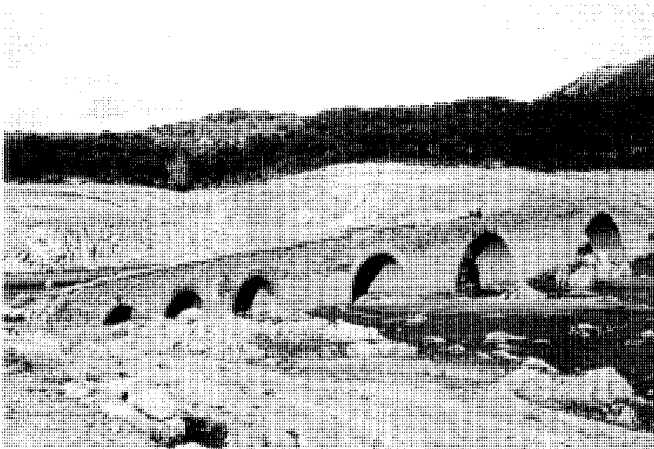
Vista general aguas abajo. Fot. Alberto Sanz.
