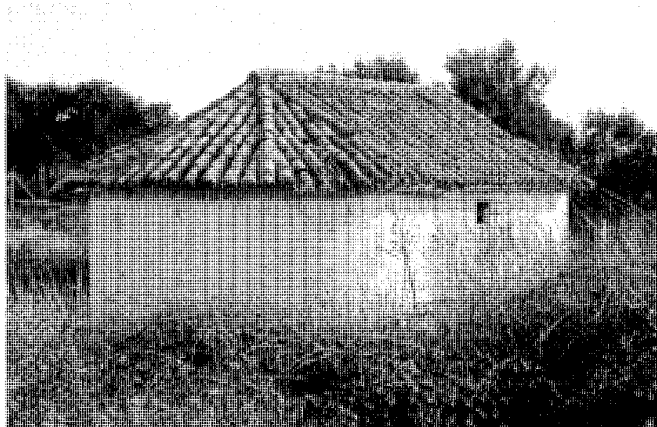
Antiguo lavadero. Fot. Actividades y Servicios Fotográficos, S.A.
