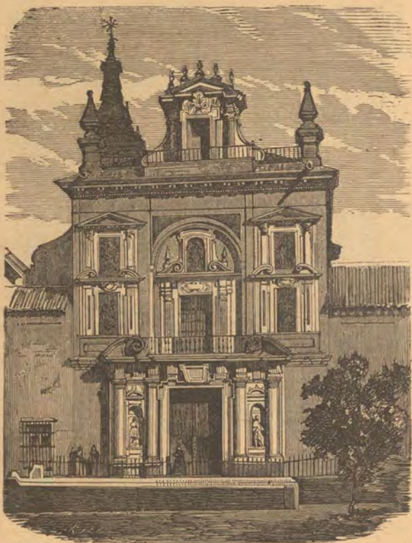
Façade de l'Hôpital, Séville.
