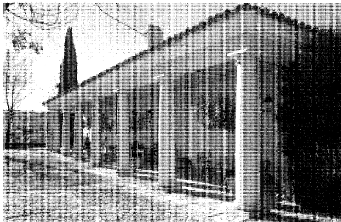
Casa del Bosque de Valdemorera. Fachada posterior.
