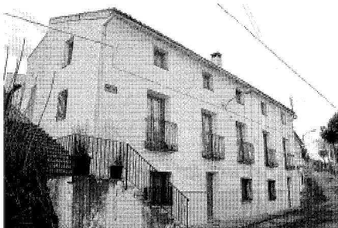
Vivienda en calle Camino del Bosque, 2.
