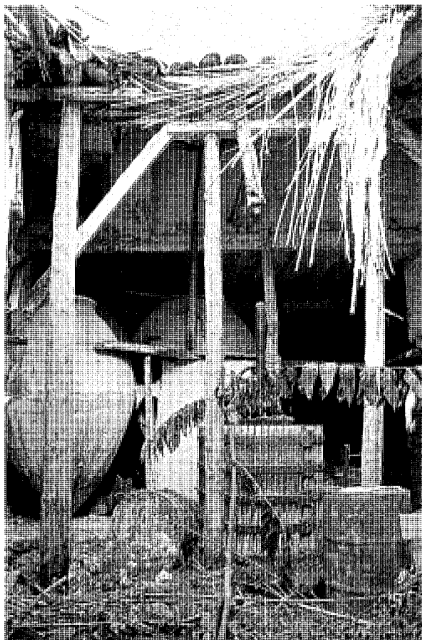
Interior de vivienda-bodega en calle Postes, 7-9.
