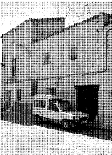
Vivienda en calle de la Fuente, 19-21.
