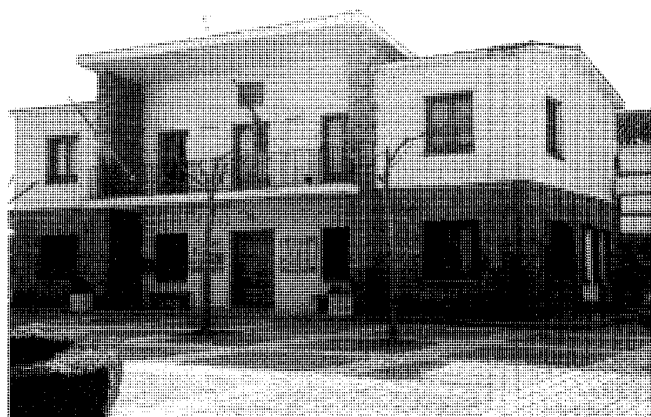
Ayuntamiento. Fot. Virginia Torres.
