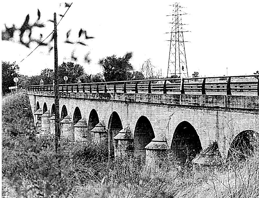
Vista del puente aguas abajo. Foto Pilar Martín-Serrano.
