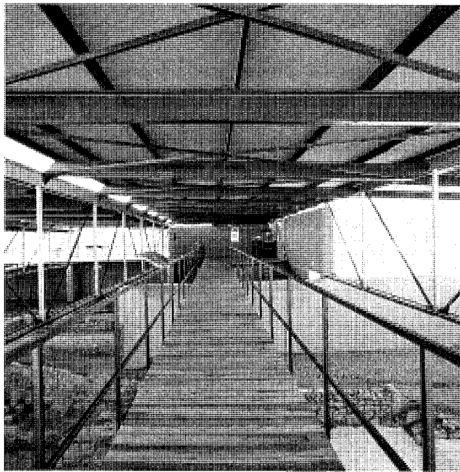
Pasarela. Fotografía cedida por los autores del proyecto.
