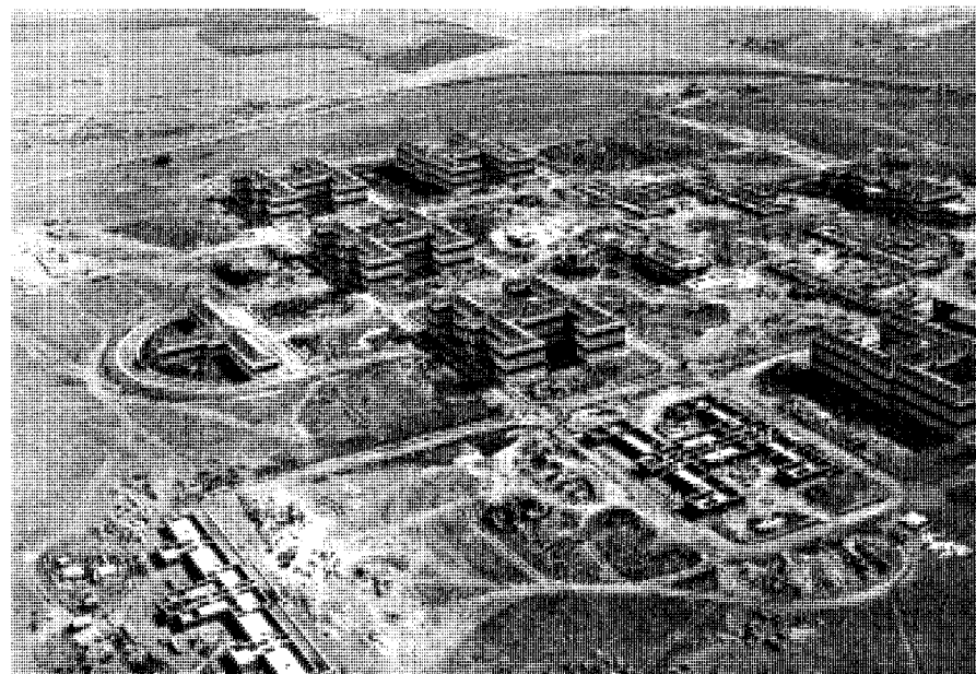
Fotografía toma da en 1935 en donde se aprecian los pabellones del psiquiátrico aún en construcción. Centro cartográfico y Fotográfico del Ejército del Aire.
