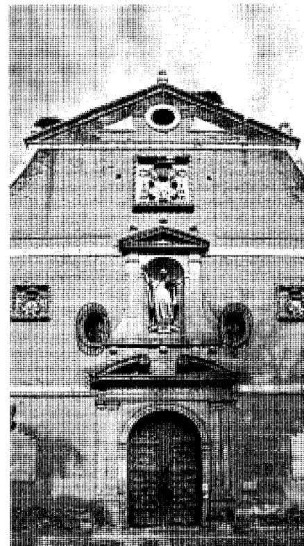
Fachada de la iglesia. Foto Jose Luis González. Cedida por el Obispado.
