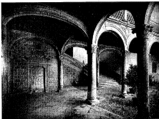
Arranque de la escalera monumental, reproducida en Die Baukunst Spaniens , cedida por el Obispado de Alcalá.
