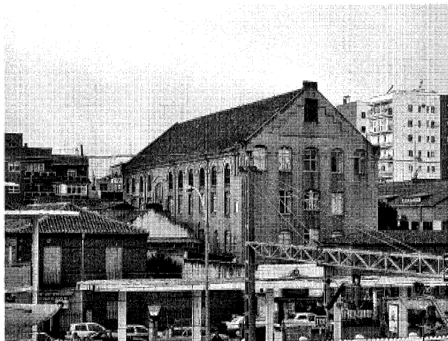
Vista de conjunto. Fotografía José Luis González, cedida por el Obispado de Alcalá.
