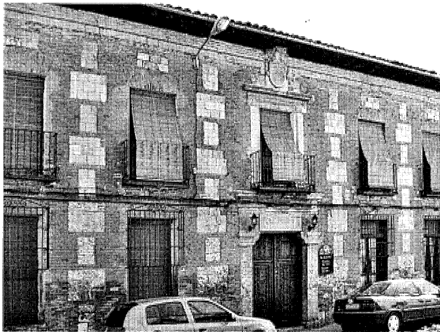
Fachada de la vivienda de la calle Empecinado 23. Foto Pilar Martín-Serrano.
