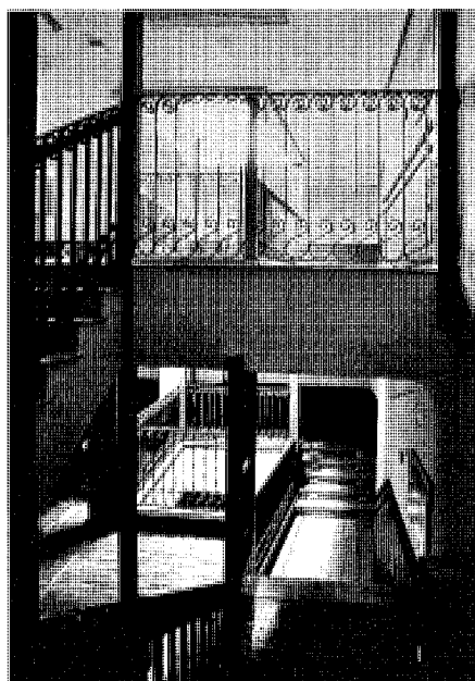
Escalera. Fotografía cedida por el autor de la rehabilitación.
