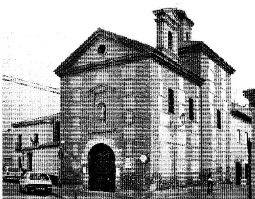
Vista de conjunto. Foto Pilar Martín-Serrano.
