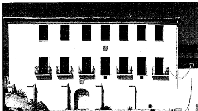
Fachada principal. Fotografía cedida por el autor de la rehabilitación.
