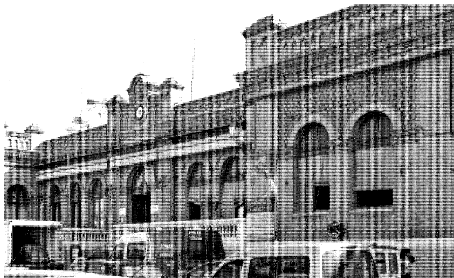
Fachada. Foto José Ablanedo.
