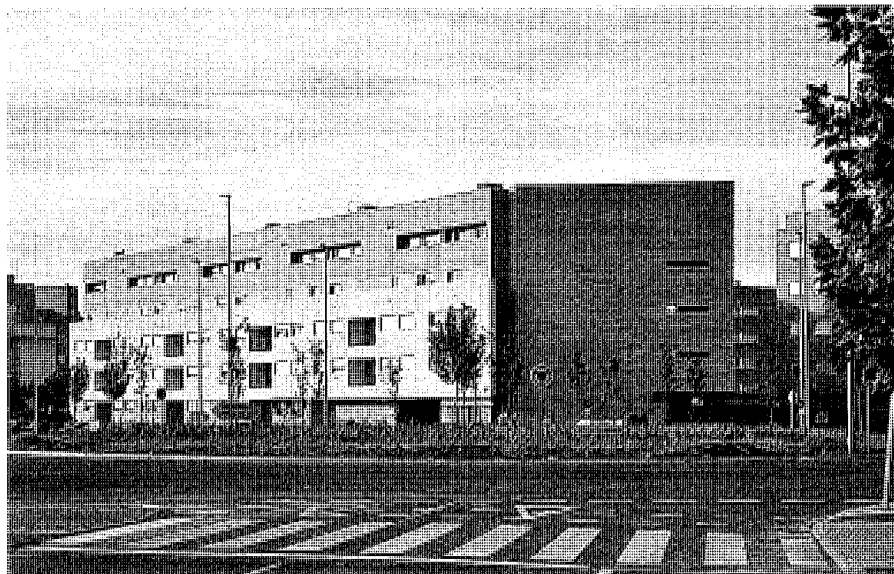
Vista de uno de los bloques que conforman el conjunto. Fotografía de los autores del proyecto.
