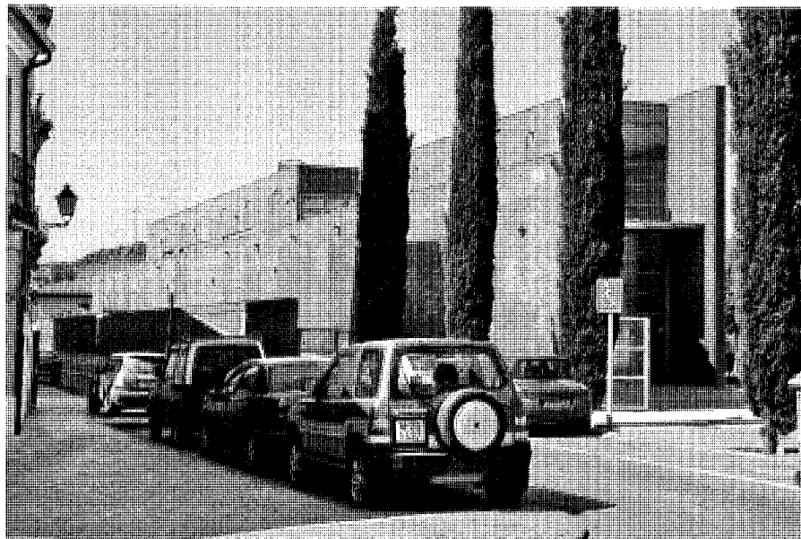
Fachada lateral. Foto José Ablanedo.
