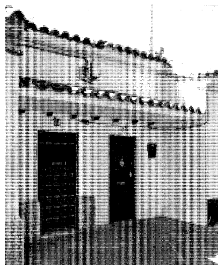
Detalle del acceso de una de las viviendas. Foto José Ablanedo.
