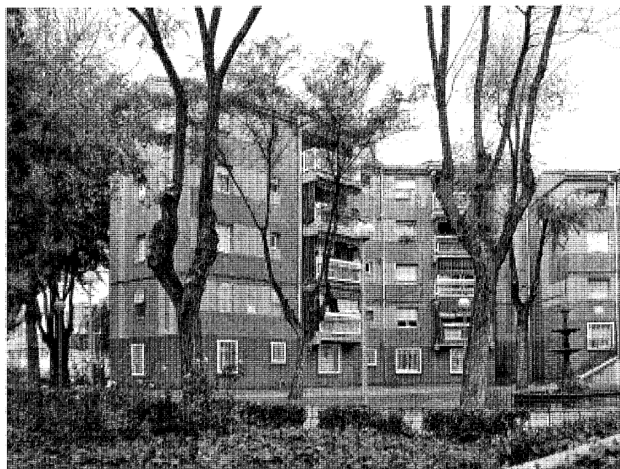
Bloques con fachada a la calle principal. Foto Pilar Martín Serrano .
