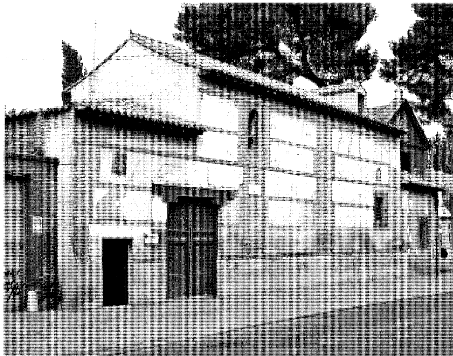
Fachada. Foto Pilar Martín-Serrano.
