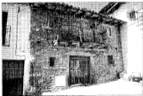
Vivienda en la calle Real, 59
