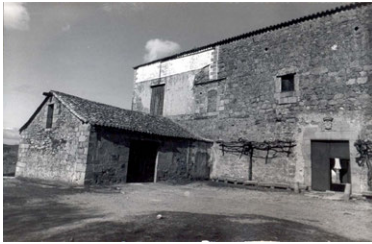
Fachada de acceso al palacio
