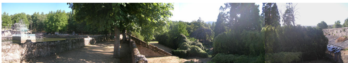
Vista del plano superior del estanque y escaleras al plano intermedio
