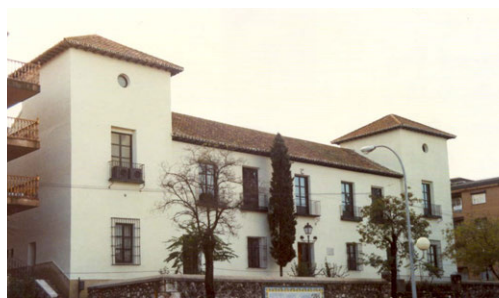
Vista actual de la Casa del Rey, Arganda (Madrid)
