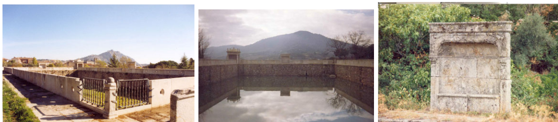
Vista del estanque, 1995
