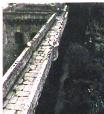
Vista del ándito. Foto Saavedra, h. 1970. CASA VALDÉS, M. de, 1973
