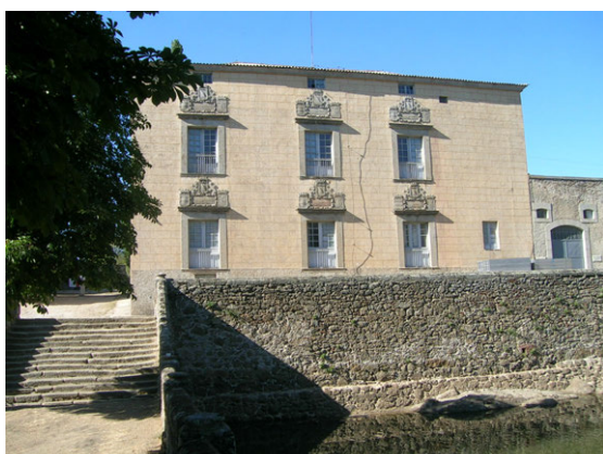
Vista del palacio
