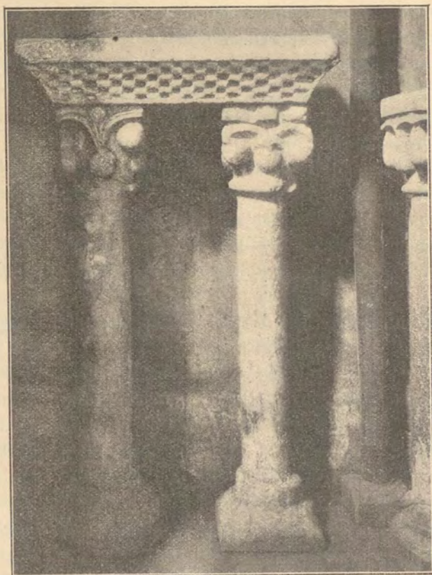
COLUMNAS PAREADAS DE LA GALERÍA INFERIOR
