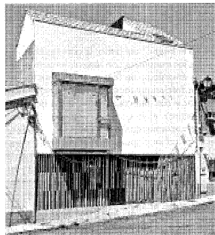
Vista de la fachada principal a la plaza de Oriente. Foto, Jose Ablanado, 2007.
