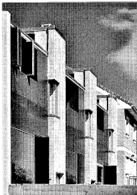
Fachada meridional interior. Foto cedida por los autores, 2006.
