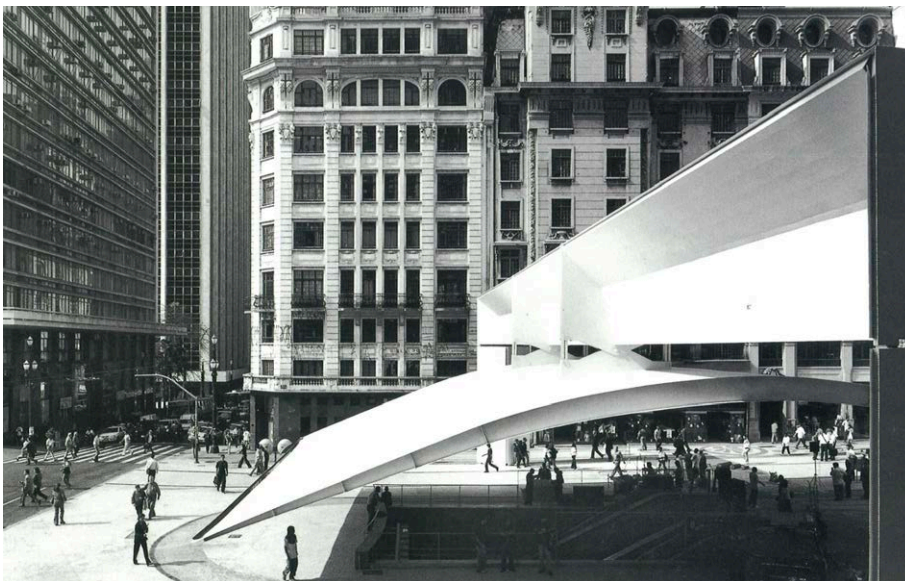
Fig.5.3.15 Remodelación de la Plaza del Patriarca. São Paulo. 1992-2002
