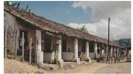
Fig.3.2.5 Azucarera Matas. Cabo de Santo Agostinho, Pernambuco. Edificio de viviendas para esclavos
