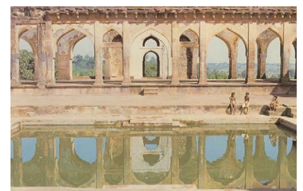
Fig.3.1.10 Palacio Baaz Bahadur . Mandu, India. Vista desde patio
