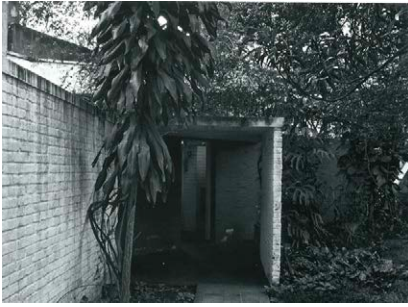
Fig.5.2.3 Vivienda del arquitecto. São Paulo, 1949 Entrada principal
