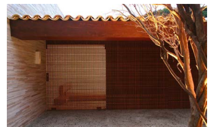
Fig.7.4.3a-b Casa Du Plessis . Río de Janeiro. 2004 Celosías en veranda
