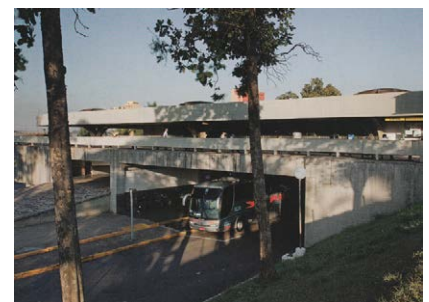
Fig.5.2.23a-b Estación de Rodoviária Jaú, São Paulo. 1973
