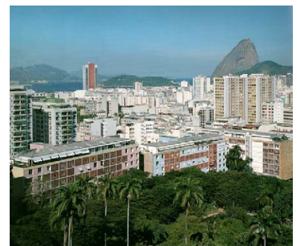
Fig.4.3.1 Edificio de Apartamentos Parque Guinle. Río de Janeiro. 1954
