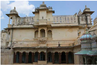
Fig.3.2.10 Mardana Mahal. Udaipur, Rajastán.
