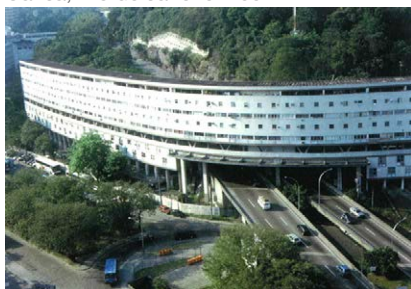
Fig.4.5.14 Conjunto Residencial Marquês de São Vicente.
