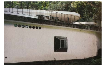
Fig.4.4.10 Casa das Canoas . Río de Janeiro. 1953 Huecos de dormitorios en basamento
