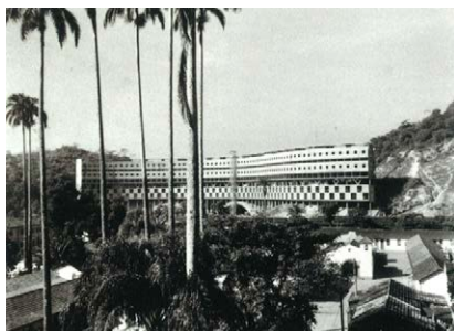
Fig.4.5.13 Conjunto Residencial Marquês de São Vicente.
