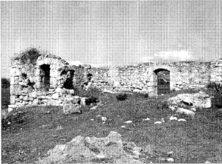
Restos de casilla del guarda del Canal
