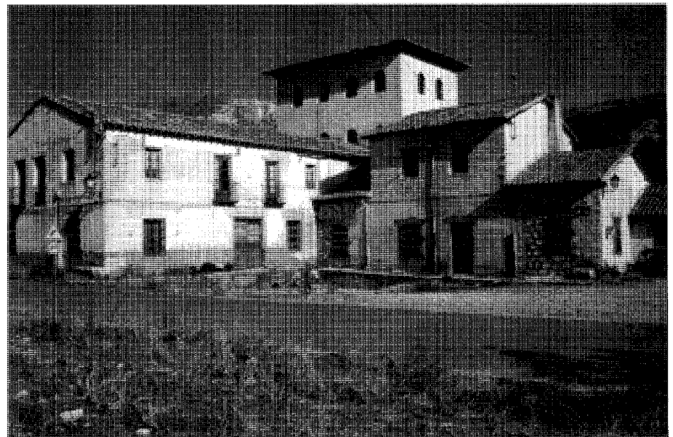
Conjunto del margen derecho de la carretera. Detalle de viviendas
