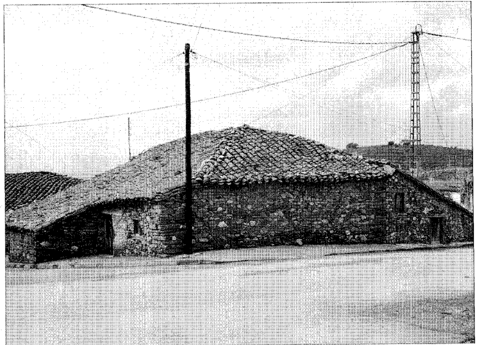
Edificio en Calle Real c/v Serrada
