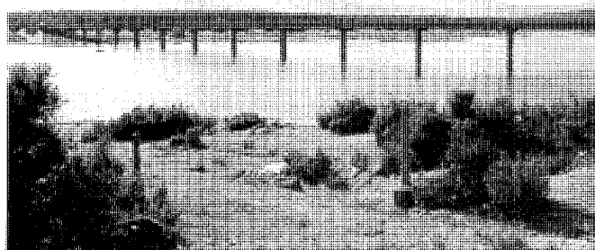
Viaducto de Valmayor. Fot. José Rodríguez Ablanedo.
