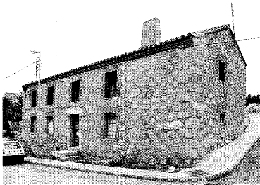
Vivienda característica del siglo XIX, situada en la calle Madrid. Fot. José Rodríguez Ablanedo.
