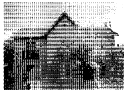
Villa en la calle de Las Cruces nº 23. Fot. José Rodríguez Ablanedo.
