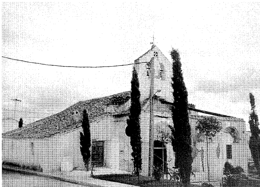
Vista general de la ermita en 1986, antes de su restauración. Información, clasificación y normativa para los cascos antiguos de la zona suroeste del ámbito de la Comunidad Autónoma de Madrid.
