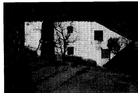
Aoslos. Vivienda en la calle Real 11
