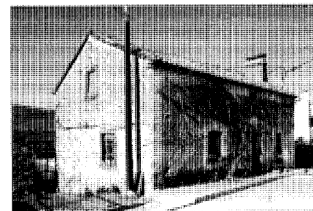
Horcajo de la Sierra. Vivienda rural aislada. Travesía de Cantarranas, 36
