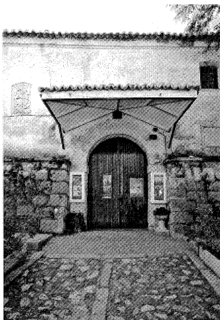
Vista del acceso.
