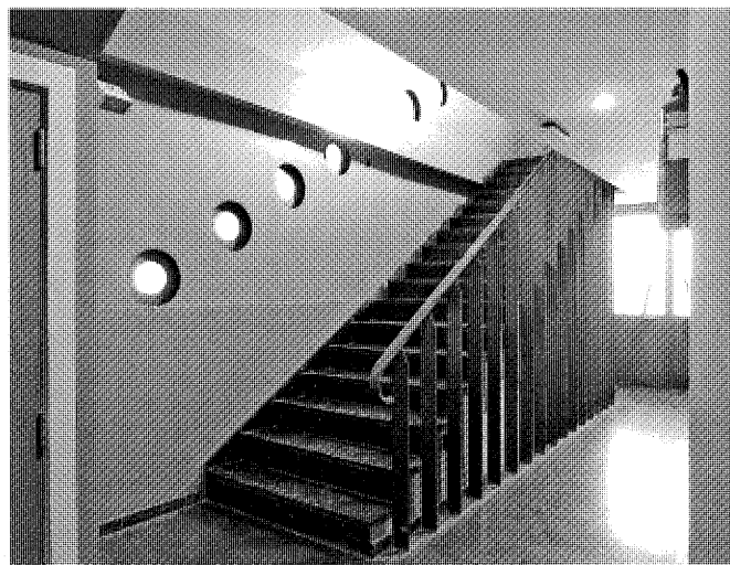
Vista de la escalera.
