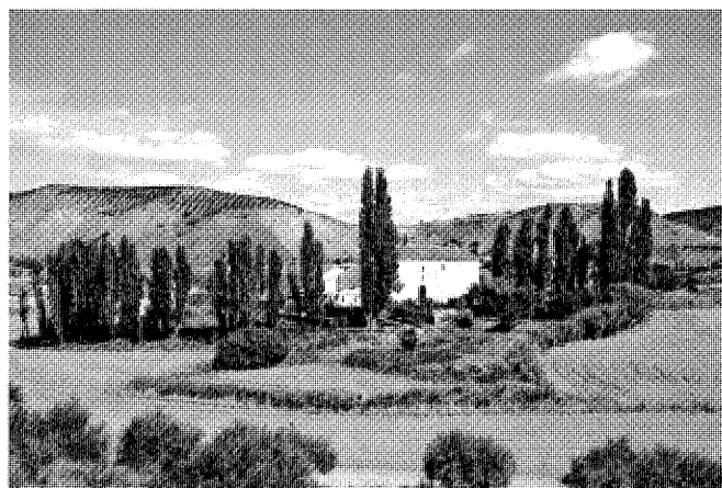
Vista del conjunto desde poniente.
