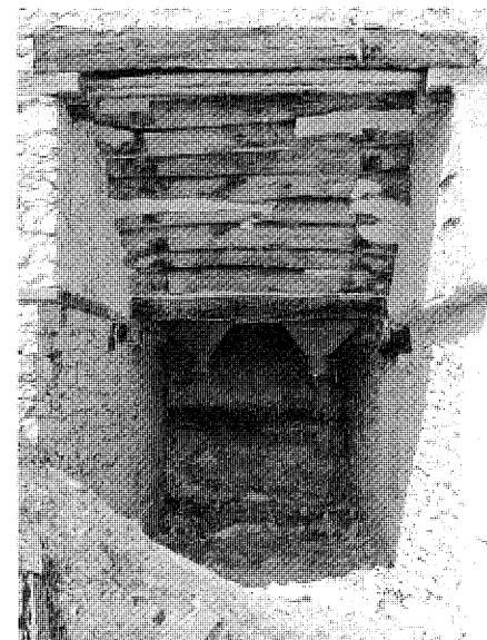
Detalle de las tolvas del producto elaborado. Foto Enrique Krahe.
