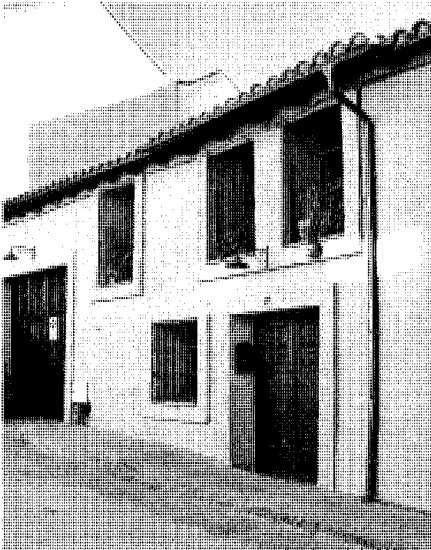
C/ de la Fragua, 15 y 17. Foto José Ablanedo.
