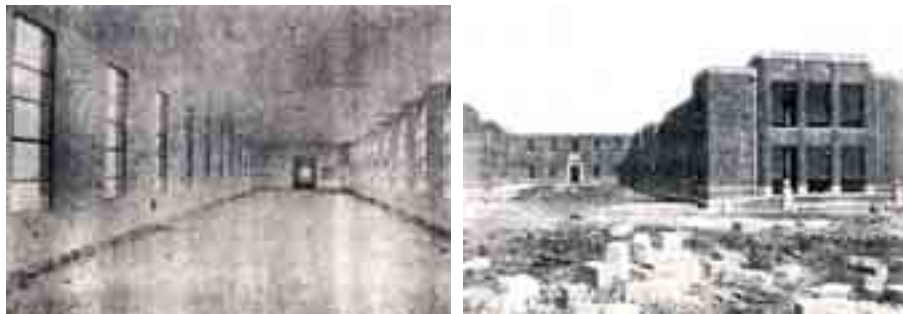
Figura 6.09 Sanatorio Español de Méjico. Galería de un pabellón destinado a enfermos con carpinterías de acero para iluminación y ventilación 1932. Vista desde el sur de los pabellones de enfermos 1932. José Arnal y Federico Reixa
