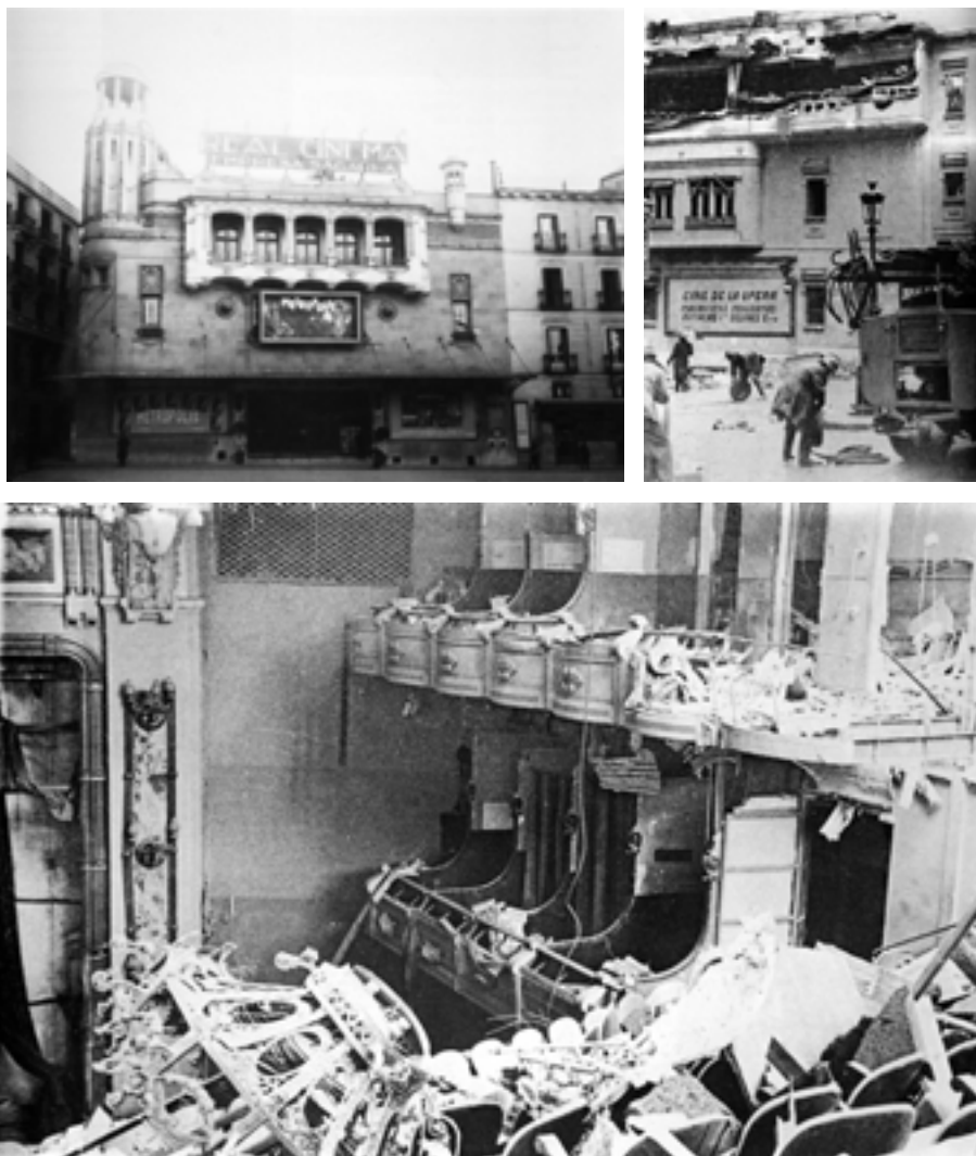
Figura 4.16 Fotografías del Real Cinema construido en Madrid en 1919. Fachada principal, y destrozos originados por los bombardeos en el exterior y en el interior de la sala. (Anasagasti 2003)
