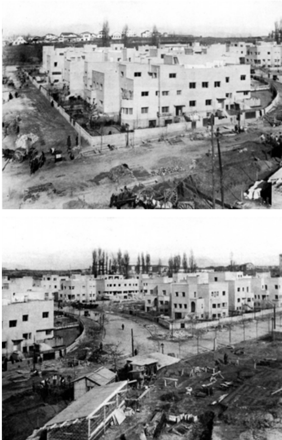
Figura 5.31 La colonia Parque Residencia en construcción. Revista Viviendas: revista del hogar nº8. Febrero 1933
