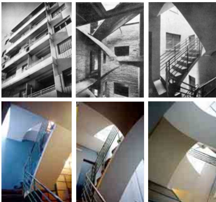
Figura 3.17 Espectaculares bóvedas tabicadas en escaleras de la modernidad española en los treinta Viviendas de alquiler en la Calle Padua en Barcelona, de Sixto Illescas.
