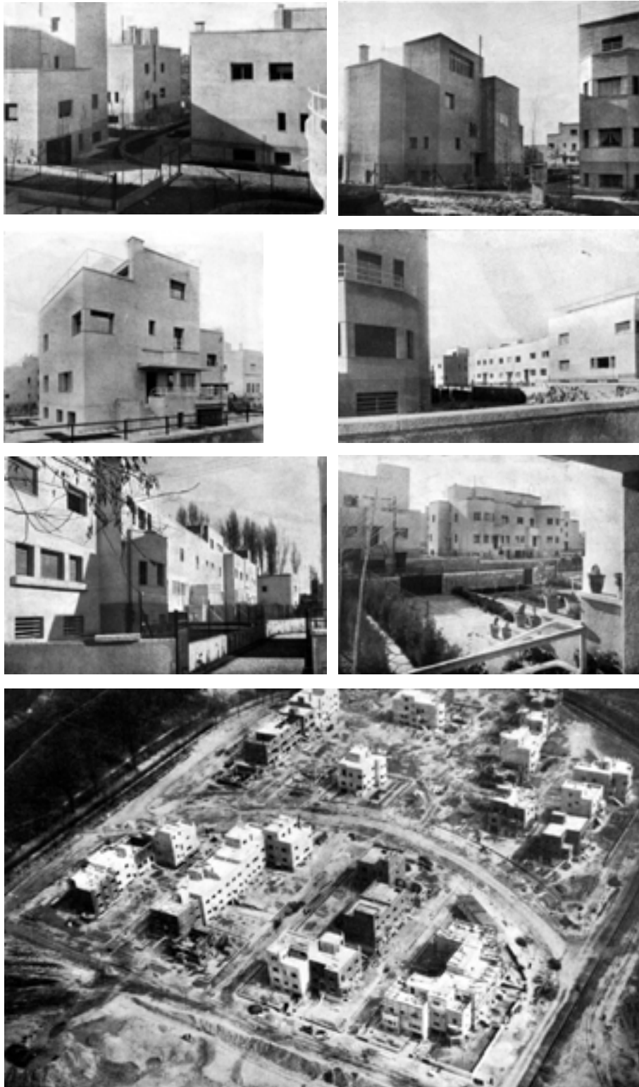
Figura 5.32 La colonia Parque Residencia en construcción. Revista Viviendas: revista del hogar nº8. Febrero 1933
